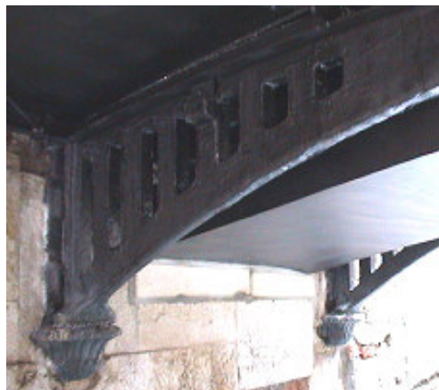
Arco del ponte Corona dopo l'intervento con FRP
