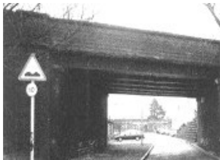
Vista generale del ponte King Street
