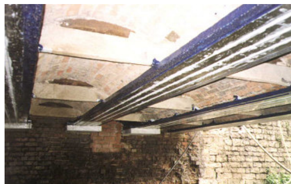
Soletta del ponte dopo l'intervento con FRP
