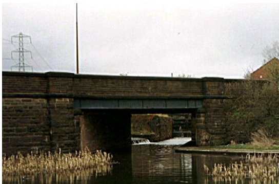
Vista generale del ponte Slattocks Canal
