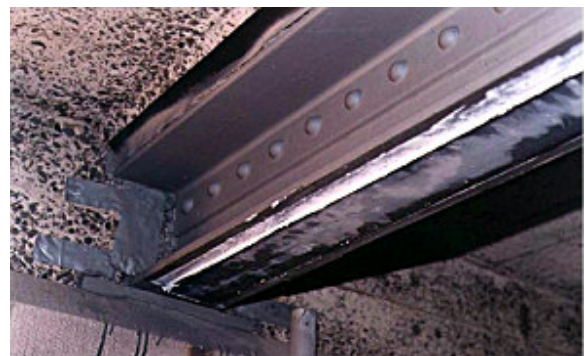
Soletta del ponte dopo l'intervento con FRP
