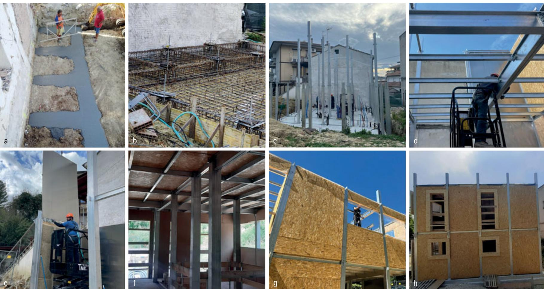
Fig. 11: Fasi di montaggio dell'edificio in lega di alluminio; (a) Getto delle travi di approfondimento della struttura di fondazione; (b) Armatura e getto della fondazione; (c) Messa in opera delle colonne; (d) Messa in opera delle travi; (e) Inserimento delle lastre di alluminio nelle maglie strutturali; (f) Vista interna della struttura completa; (g) Montaggio dei pannelli di facciata; (h) La struttura è completa di tamponatura.
