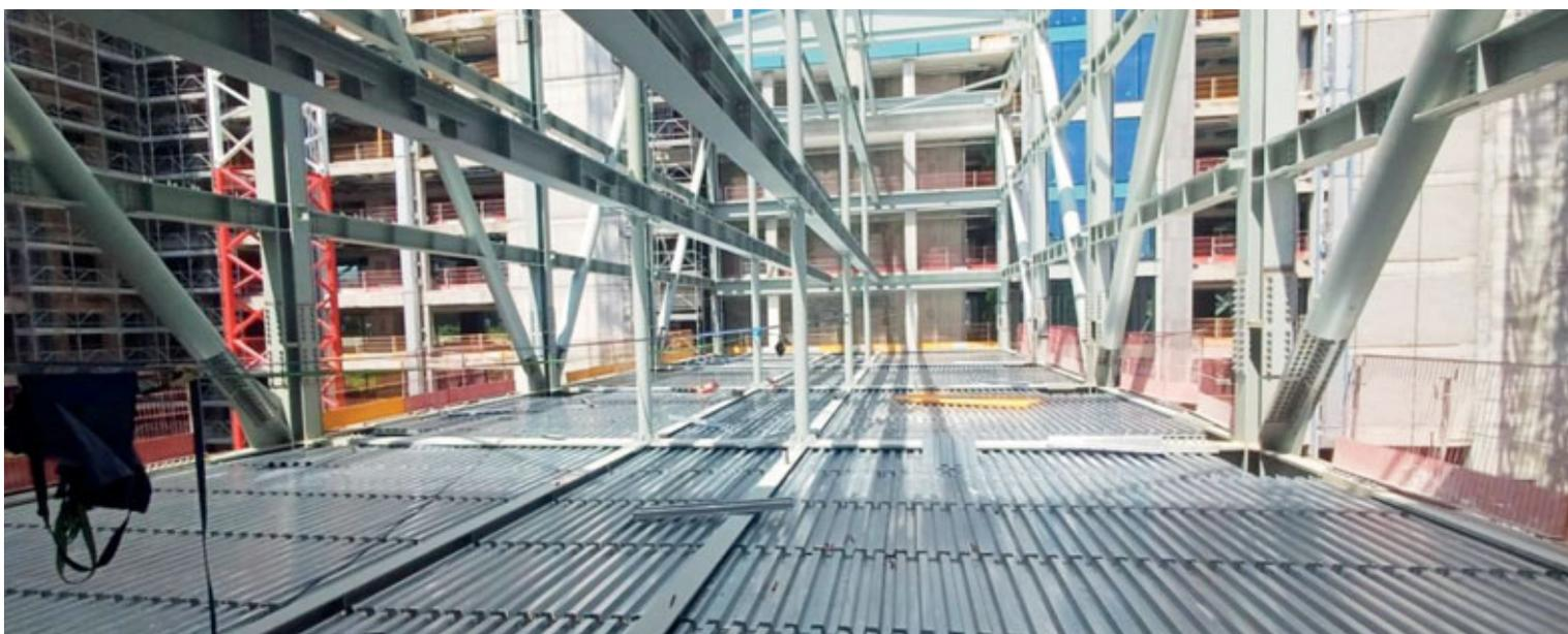
Figura 32: Termine della fase 10 del montaggio (preparazione al getto lamiere piano 2°).
