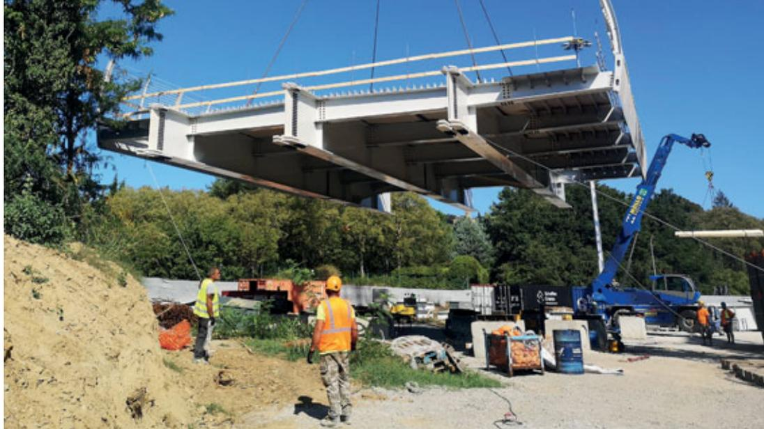
Fig. 11: Il varo di un macroconco da 20 m allestito per le operazioni di finitura.
