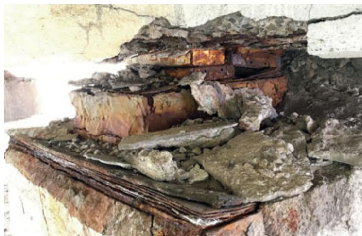
Fig. 3: L'appoggio "esploso" in un quadro di incipiente degrado dei getti.
