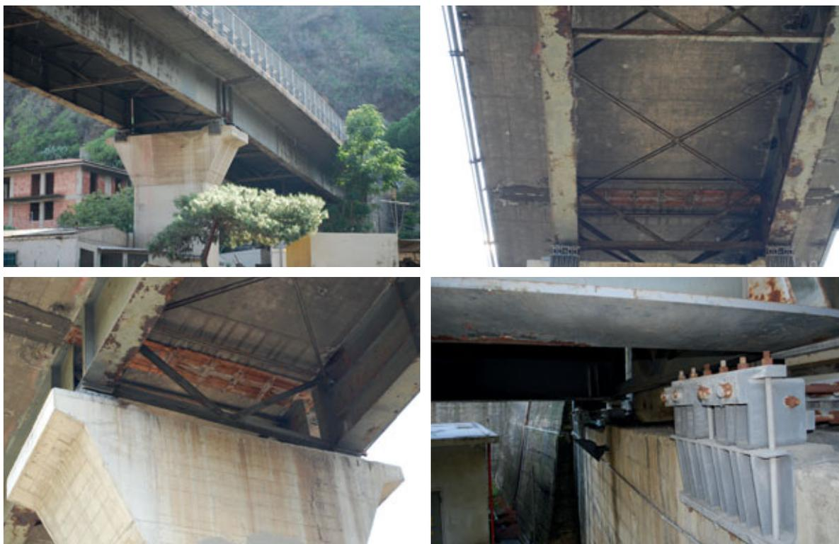
Fig. 1: Immagini di uno dei ponti investigati: a) prospetto; b) e c) vista dal basso; d) particolare di uno degli appoggi.
