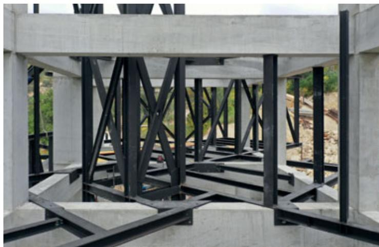
Fig. 18: Struttura in acciaio costruita sul telaio esistente, campata interna. ©FONDAMENTA.
