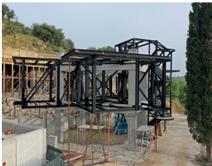
Fig. 17: Struttura in acciaio costruita sul telaio esistente, lato nord. ©FONDAMENTA.
