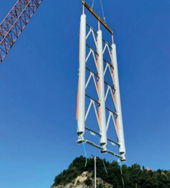
Fig. 10: Il varo del puntone più lungo (20 m).
