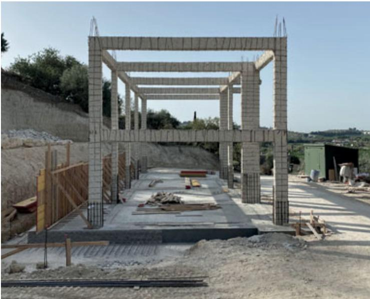
Fig. 20: Struttura esistente in c.a. rinforzata tramite incamiciatura.
