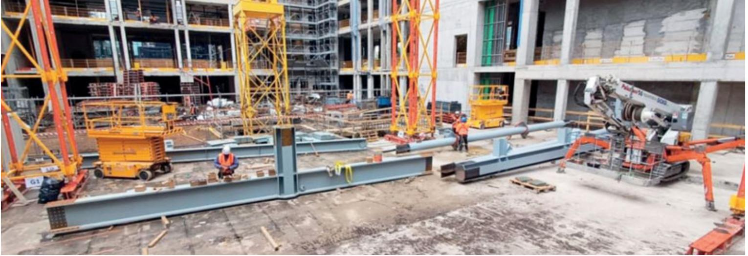
Fig. 27: Inizio montaggio con spider crane e PLE per montatori e torri provvisionali (vedi cap. successivo montaggio).
