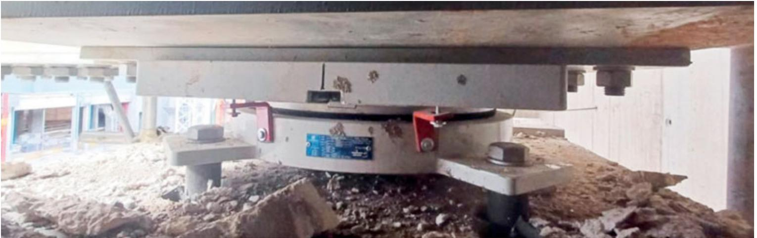
Fig. 28: Posa apparecchio di appoggio monodirezionale e centraggio sul pulvino in c.a.
