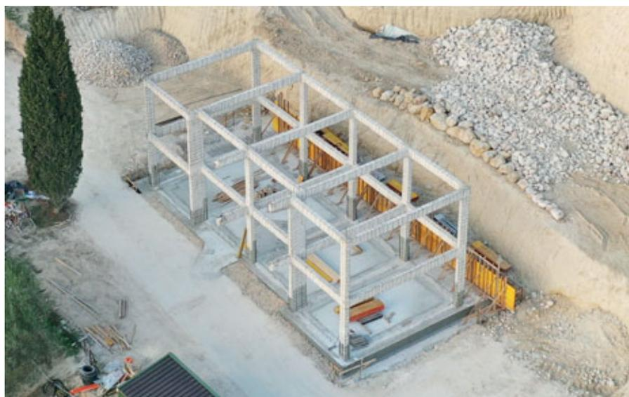
Fig. 3: Vista panoramica della struttura esistente in c.a. ©FONDAMENTA.
