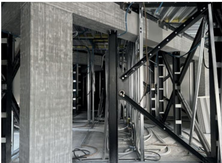
Fig. 29: Dettaglio dei controventi concentrici a X. ©FONDAMENTA.
