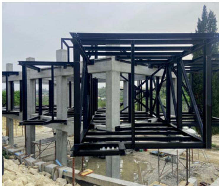
Fig. 16: Struttura in acciaio costruita sul telaio esistente, lato a monte. ©FONDAMENTA.
