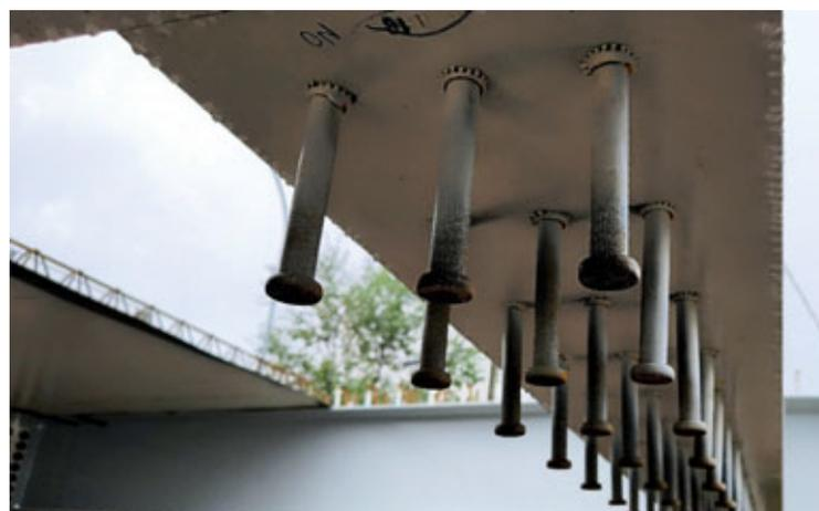
Fig. 13: Il dormiente in chiave all'arco con la doppia piolatura di estradosso ed intradosso.
