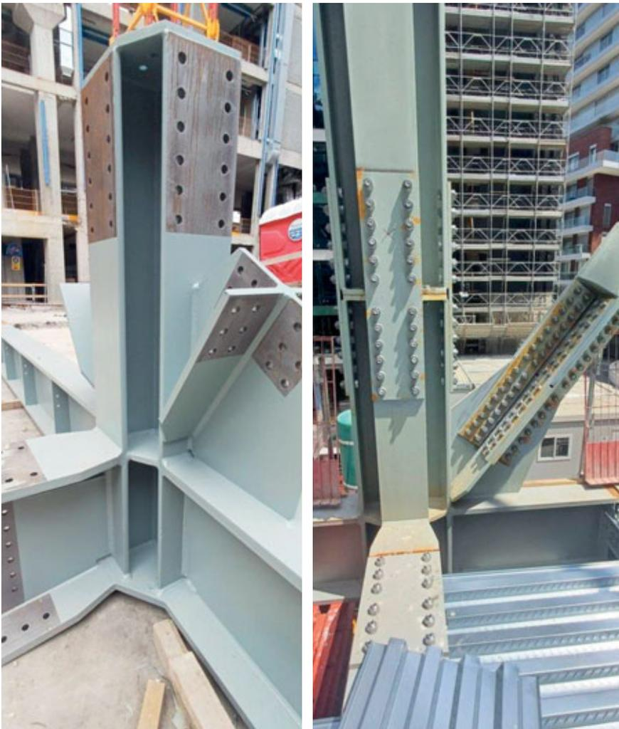
Fig. 24: Smistamento pezzi a terra e imbullonamento per imbastitura diagonali e montanti.
