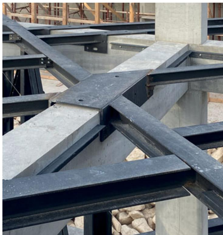
Fig. 27: Dettaglio a sella delle travi in acciaio sul telaio in c.a. ©FONDAMENTA.
