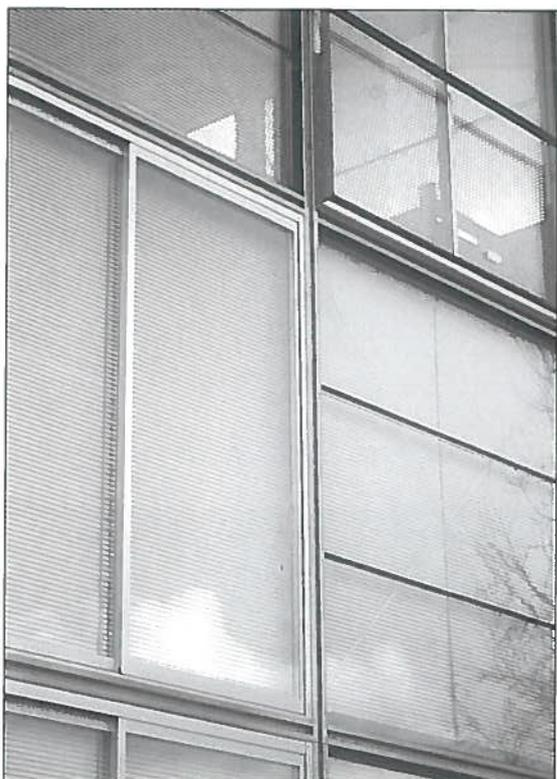
Fig. 16. Particolare della facciata rivolta a nord: l'involucro è costituito da un sistema a montanti e traversi che regge pannelli fissi e serramenti scorrevoli a tutt'altezza.
