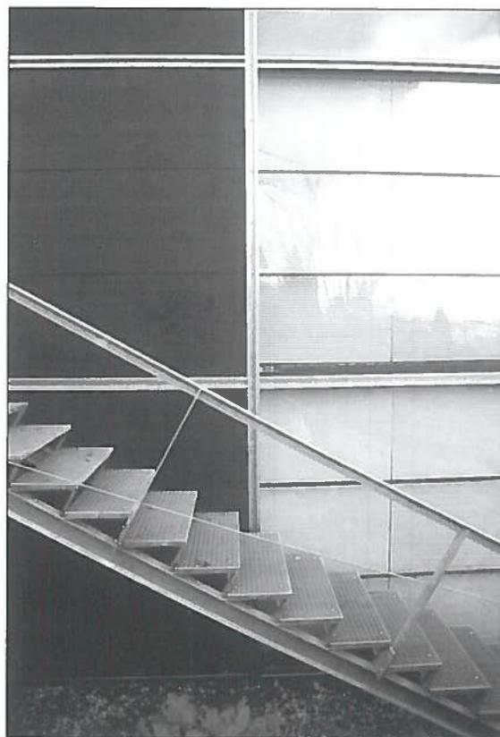
Fig. 19. Vista del fronte est dell'edificio: la scala esterna è costituita da una struttura in acciaio, con gradini in grigliato metallico.
