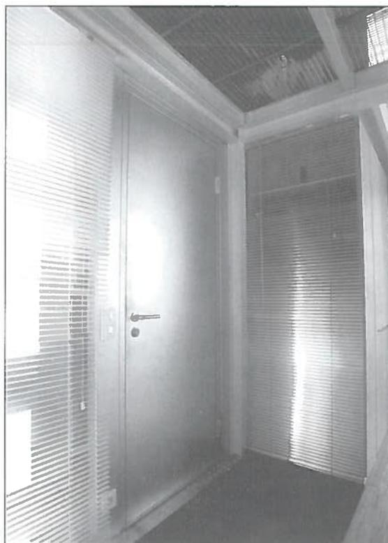
*Fig. 25. Vista della zona di ingresso: è possibile notare la presenza di un grigliato che funge da ballatoio distributivo per il piano superiore e da soffitto per la zona di ingresso, ponendo in continuità visiva e percettiva le zone di distribuzione.*
