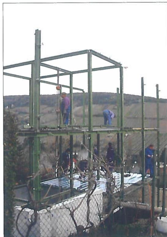
Fig. 8. Vista dell'edificio in costruzione: la leggerezza dei componenti ha consentito di fare a meno di mezzi di sollevamento meccanico e sono stati sufficienti pochi operai per realizzare il montaggio degli elementi.
