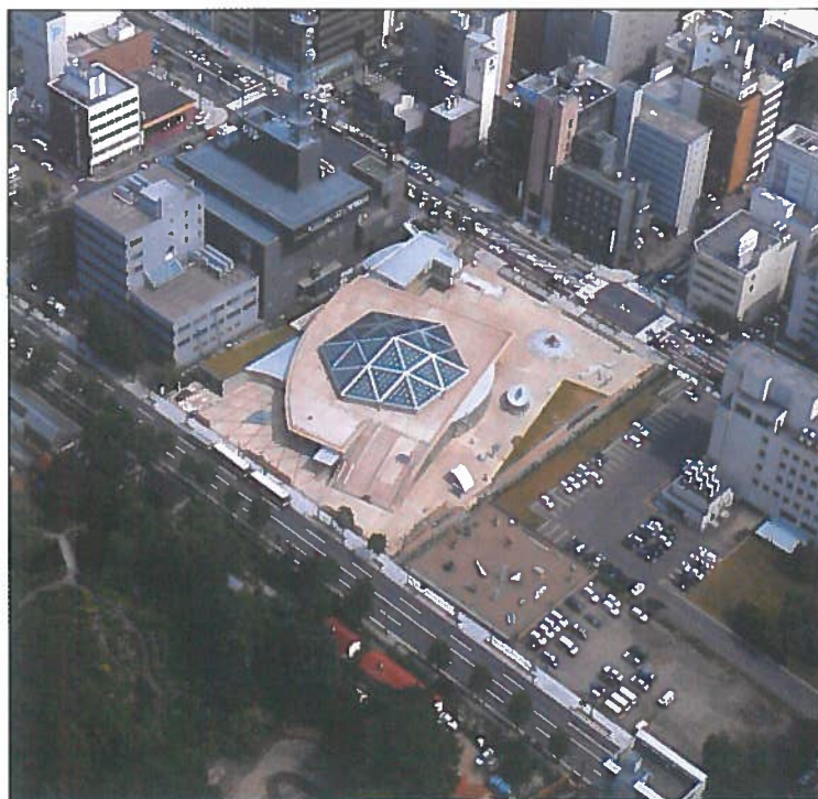
Vista aerea del Sapporo Media Park. Al centro, la copertura trasformabile in acciaio e vetro nell'assetto chiuso.
