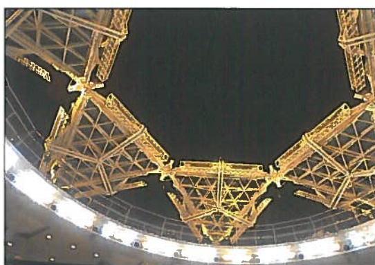
A destra: Particolari delle fasi di trasformazione della copertura. Durante gli eventi programmati in notturna nell'anfiteatro, l'atto di apertura della copertura assume esso stesso il carattere di evento straordinario e spettacolare.
