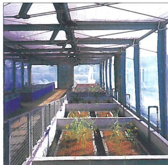
L'involucro trasparente del Padiglione, caratterizzato da struttura portante in acciaio e rivestimento di cuscini pneumatici in membrana ETFE.
