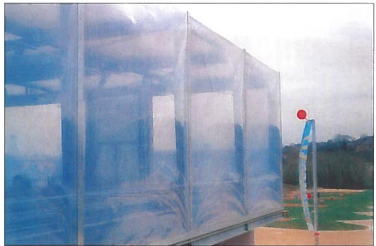
L'involucro trasparente del Padiglione, caratterizzato da struttura portante in acciaio e rivestimento di cuscini pneumatici in membrana ETFE.
