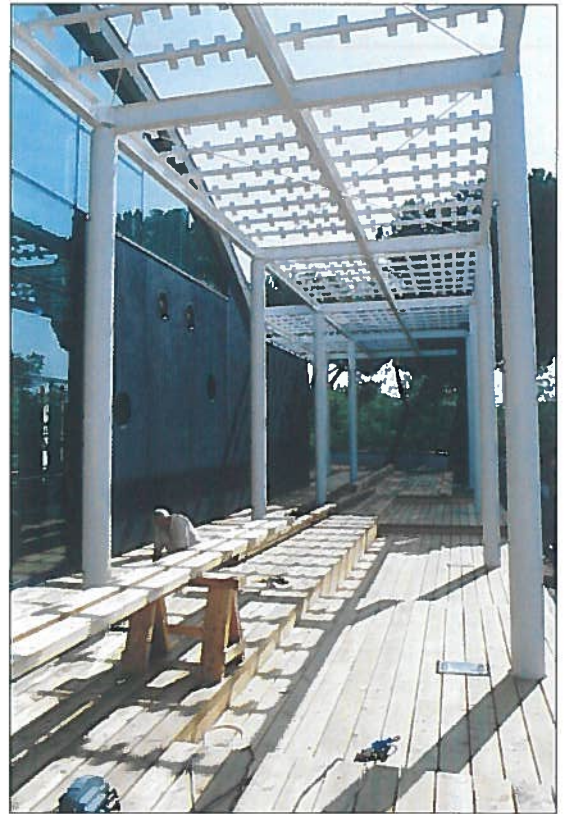
Fig. 12 La costruzione della pavimentazione flottante pensata per uniformare le diverse funzioni del Campus. Scorcio sulla biblioteca a nord (Fonte: Archivio 5+1 Associati)
