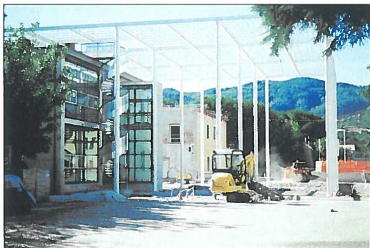
Fig. 3 Scorcio interno delle operazioni di cantiere in atto nell'area delle ex- Camerate (Fonte: Archivio 5+1 Associati)
