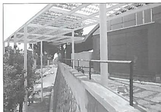
Fig. 22 - Scorcio prospettico della biblioteca sul portico principale a nord-est. In primo piano, in basso: l'approdo della scala in muratura realizzata per l'accesso all'Acropoli del Campus (Fonte: Archivio 5+1 Associati)
