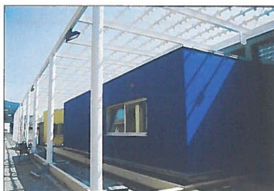
Fig. 16 - Scorcio di dettaglio sui corpi in muratura pensati per i servizi alla biblioteca. In primo piano, in basso: la carpenteria lignea della pavimentazione a zattera (Fonte: Archivio 5+1 Associati)
