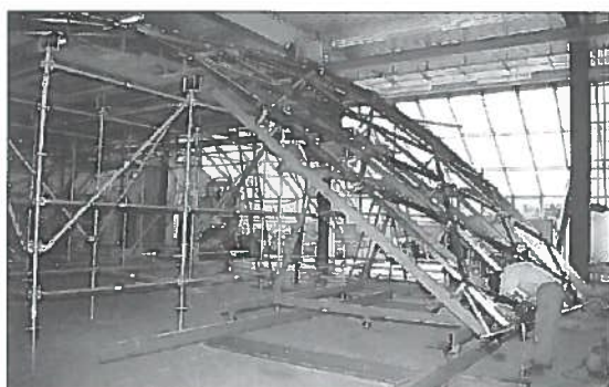
Fig. 16: Le parti più delicate da montare sono state quelle curve perimetrali, che dovevano essere predisposte per l'aggancio al tetto piano.
