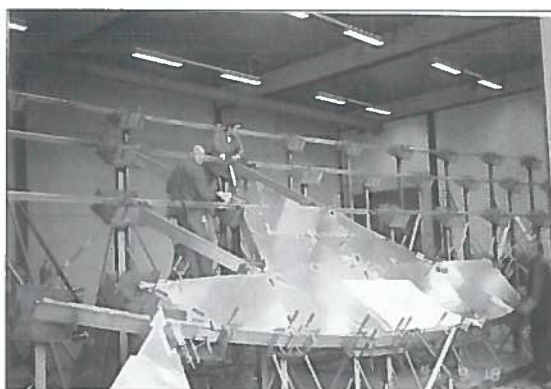
Fig. 15: Montaggio della struttura. Essa è stata fissata in modo temporaneo e realizzata in parti con dimensioni trasportabili.
