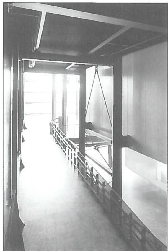
Fig. 23. Scorcio parziale delle rampe metalliche interne verso la testata ovest. In primo piano, a destra, la sala proiezioni pensile (Fonte: archivio studio Bucas).
