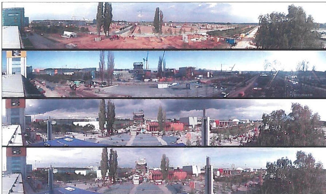
Fig. 1. Vista panoramica dell'area Pavilliongelande Ost durante le operazioni di cantiere (Fonte: archivio EXPO 2000 Hannover GmbH).
