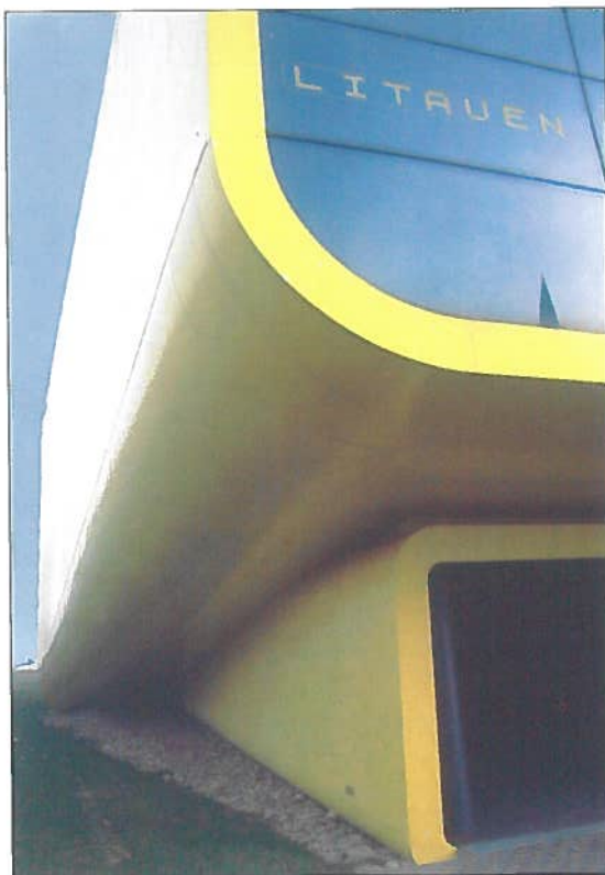
Fig. 13. Scorcio parziale dell'oggetto apparente ricercato per il corpo principale (quota +3,30 m) in corrispondenza della testata ovest - ingresso. In evidenza, in basso a destra, l'appoggio strutturale passante per il volume principale. (Fonte: foto dell'autore).
