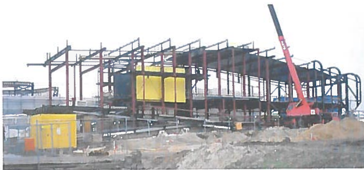
Fig. 10. Vista generale dell'impalcato strutturale pensato per la costruzione del padiglione. All'interno della gabbia portante risalta il volume acceso della sala cinematografica (Fonte: archivio studio Bucas).
