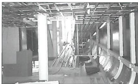
Fig. 15. Scorcio interno della gabbia metallica pensata per la continuità strutturale dei rivestimenti e dei supporti tra livello terra e coperture (Fonte: archivio studio Bucas).
