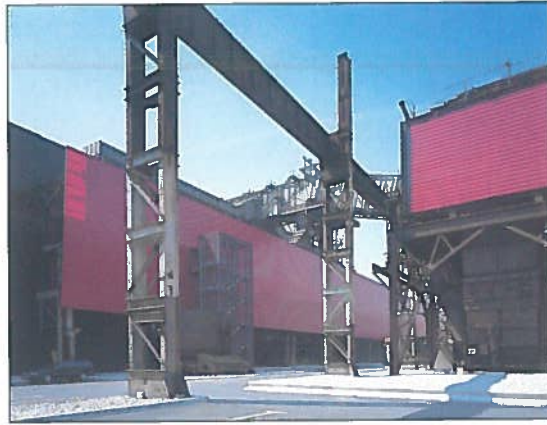
5. Scorcio esterno sulle pilastriature pre-esistenti e sui rivestimenti policromi dei fronti (Fonte: Morley von Steenberg per Wilkinson-Eyre Architects)
