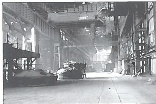
2. Scorcio interno della navata principale della fonderia (Fonte: Wilkinson-Eyre Architects)
