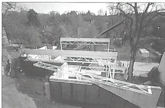
Fig. 8. Elementi componenti il sistema portante dell'edificio.
