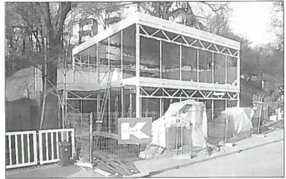
Fig. 12. Fasi di ultimazione del montaggio della struttura portante.
