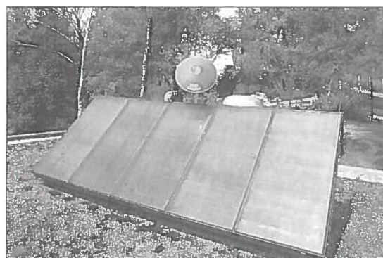
Fig. 17. Vista della copertura con i collettori solari.
