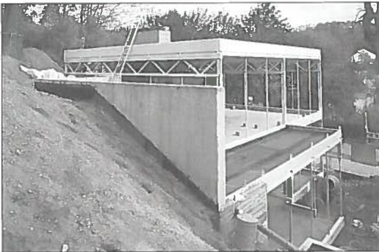
Fig. 13. Vista di una fase di cantiere dalla sommità del pendio con in primo piano il muro di contenimento.
