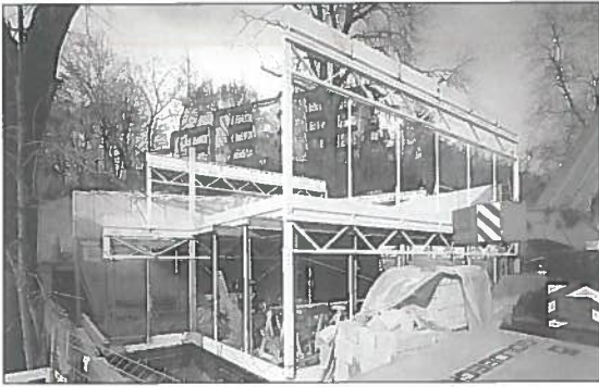
Fig. 11. Fase di montaggio della struttura portante.
