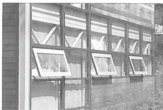
Fig. 10. Vista del fronte sud dell'edificio. Attraverso l'involucro vetrato rimane visibile, al di sopra delle travi reticolari, il pacchetto di pavimentazione, che viene contenuto da un profilo in acciaio che funge da rifinitura.
