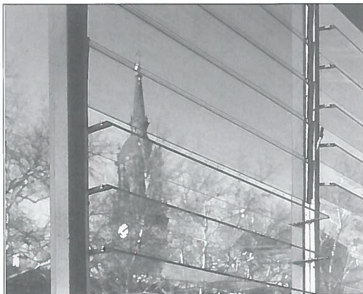
Fig. 13. Vista in dettaglio delle lamelle orizzontali in vetro dei giardini d'inverno.
