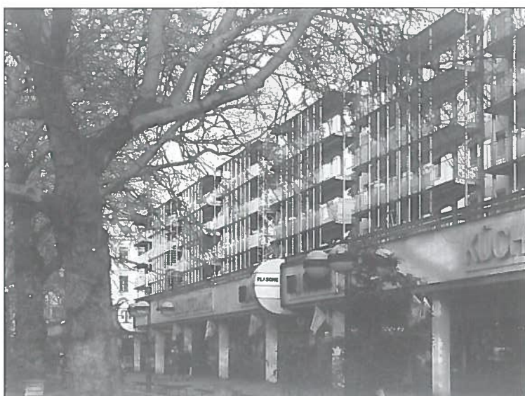
Fig. 3. Vista dell'edificio dopo la riqualificazione.
