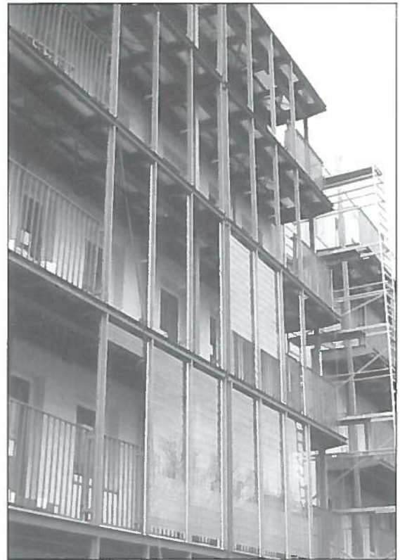
Fig. 10. Vista di una fase della costruzione.
