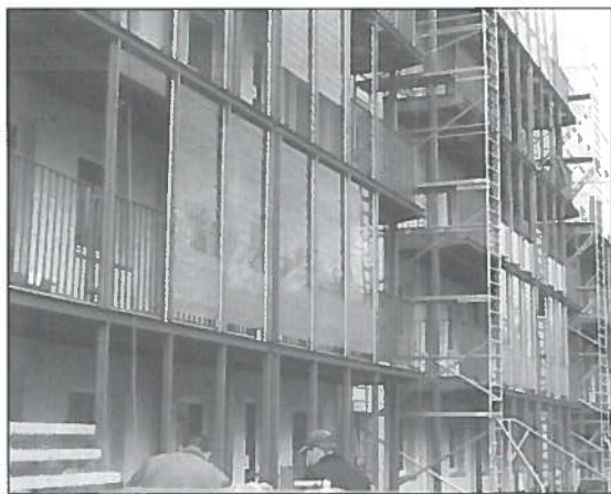
Fig. 11. Vista di una fase della costruzione.
