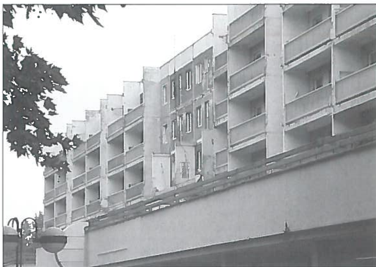
Fig. 2. Vista dell'edificio non ancora riqualificato, con i vecchi balconi in cemento armato.
