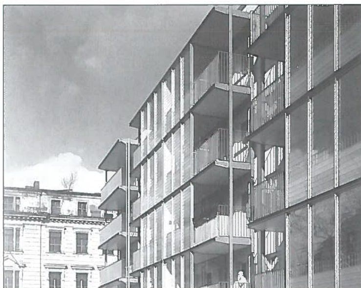
Fig. 14. Vista dell'intervento ultimato.
