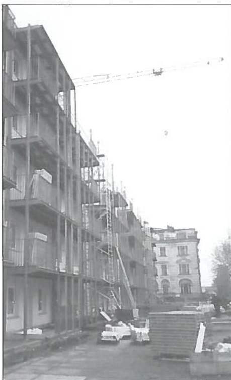
Fig. 9. Vista di una fase della costruzione.
