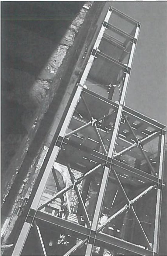
Fig. 18. Restauro della Cartiera del Fibreno a Isola del Liri. Scorcio della torre dei collegamenti verticali e di sostegno della passerella di ingresso in costruzione.
