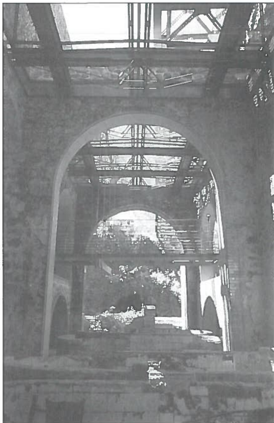
Fig. 22. Restauro della Cartiera del Fibreno a Isola del Liri. Vista dell'interno del museo con la copertura trasparente e la passerella di distribuzione interna in costruzione.
