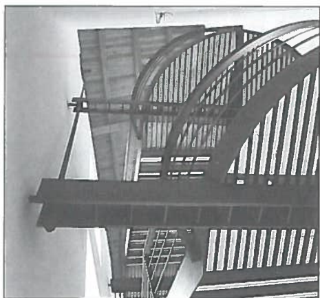
Fig. 14. Restauro del Convento francescano dei Minori Conventuali a Sora. Vista dal basso della scala realizzata con la tecnica della sospensione diretta che collega in corrispondenza all'area delle esposizioni permanenti i tre piani dell'edificio.
