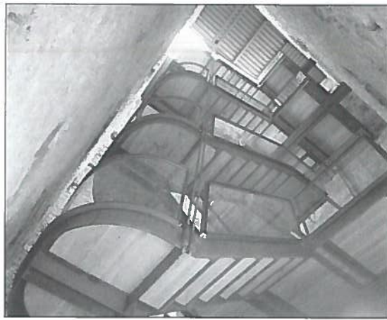
Fig. 8. Restauro di Castello Caetani a Trevi. Vista dal basso della scala a sospensione diretta situata nella torre.
