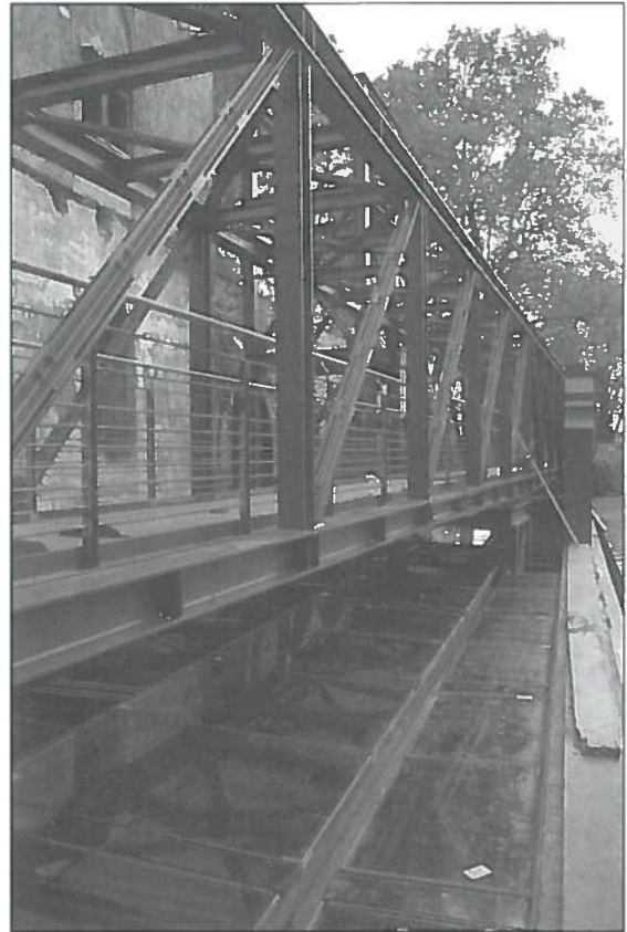
Fig. 19. Restauro della Cartiera del Fibreno a Isola del Liri. Vista della passerella di ingresso al museo.
