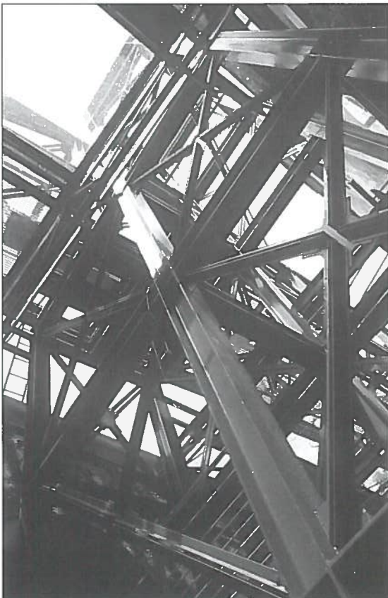
Fig. 20. Restauro della Cartiera del Fibreno a Isola del Liri. Dettaglio della struttura della torre di collegamento verticale.
