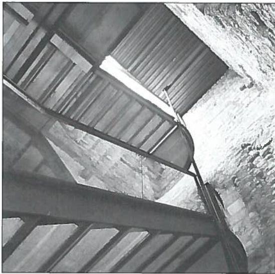
Fig. 9. Restauro di Castello Caetani a Trevi. Dettaglio dal basso della scala a sospensione diretta situata nella torre.
