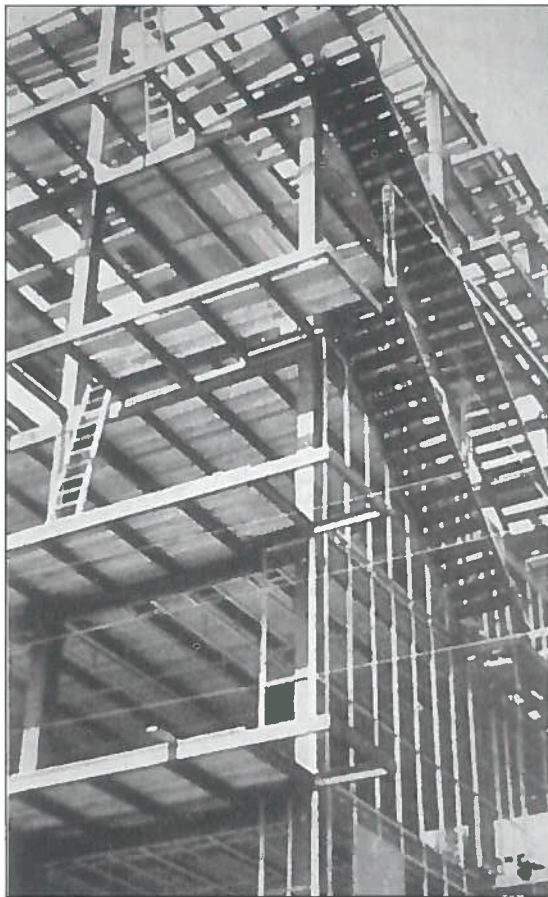
Fig. 22 - Immagine della abitazione tipica ed abitazione tipica a struttura di acciaio (1933, Milano) durante la realizzazione. Questo edificio, come la casa in acciaio sono oggi a Riccione, in quanto smontati e rimontati per essere utilizzati come ampliamento di una struttura alberghiera. Si veda, per maggiori dettagli D'Orazio M., Note sull'impiego della struttura intelaiata in acciaio, in Costruzioni Metalliche n. 3/2000, ACAI, Milano.
