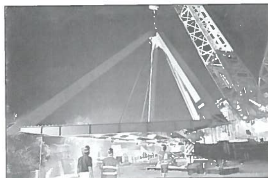
Figura 22 Fasi del varo. sollevamento dagli appoggi provvisori e rotazione dell'impalcato
