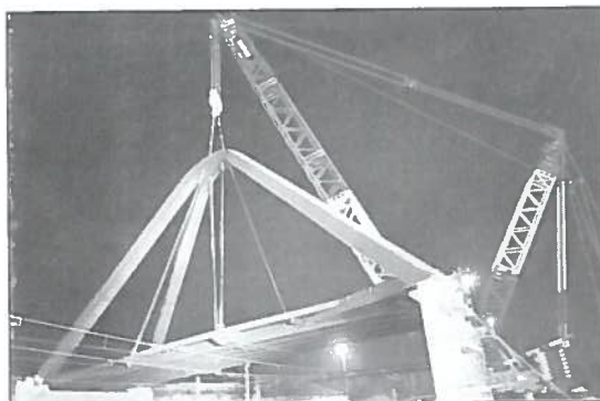
Figura 21 Fasi del varo in "notturna"
