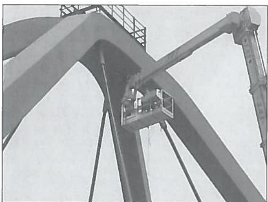
Figura 19 - Dettaglio stralli, nodo di chiave arco
