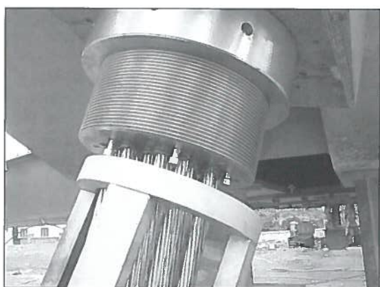
Figura 18 - Dettaglio stralli, ancoraggio mobile
