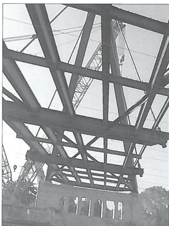
Figura 25 - Il ponte è posato sulle pile spalle
