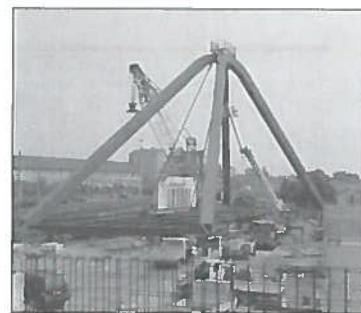
Figura 17 - Impalcato assemblato a lato ferrovia
