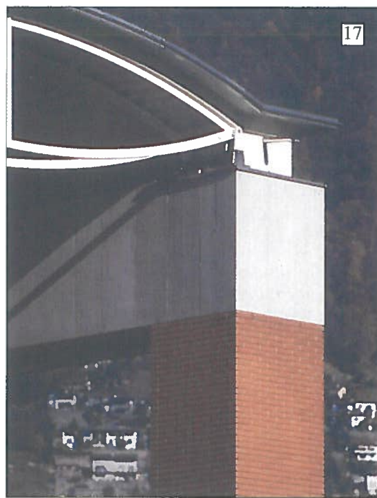
Fig. 17. Centro sportivo, Tenero. Dettaglio della soluzione d'angolo della copertura del portico.
