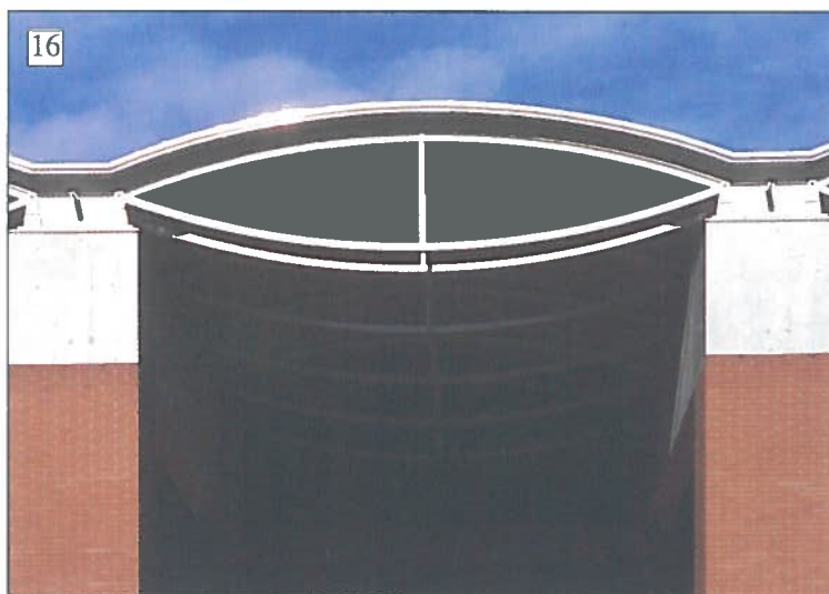
Fig. 16. Centro sportivo, Tenero. Dettaglio della trave a fuso.
