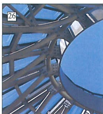
Fig. 26. Museo d'arte moderna e contemporanea, Rovereto. Dettaglio del fissaggio delle travi reticolari all'anello centrale.
