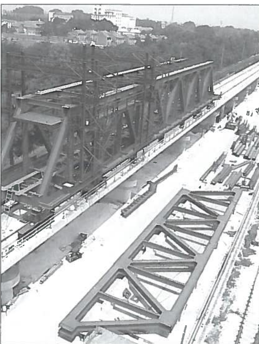
Figura 58 - Alesatura su travata assemblata
