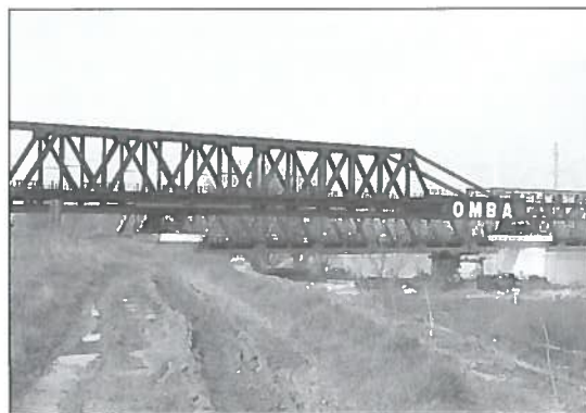
Figura 70 - Avambecco e prima fase di varo
