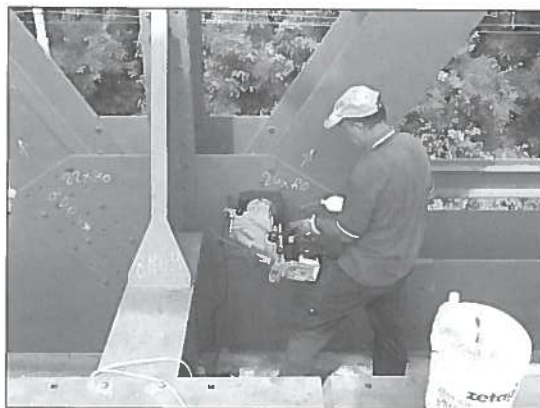
Figura 64 - Alesatura
