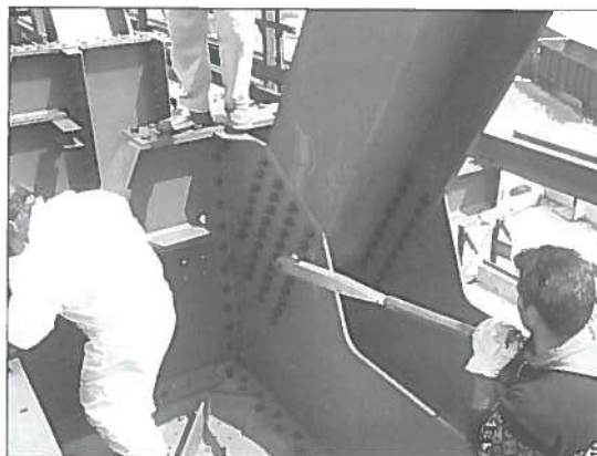
Figura 65 - Serraggio bulloni con chiave dinamometrica
