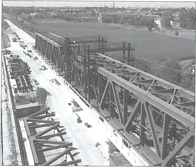
Figura 63 - Cantiere di assemblaggio
