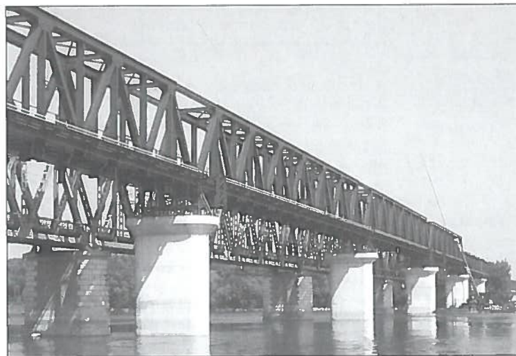
Figura 11 - Nuovo ponte FS sul PO
