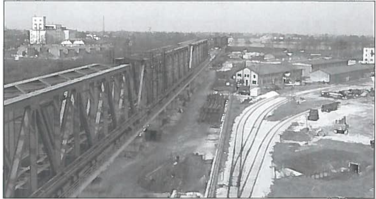
Figura 48 - Vista aerea del cantiere
