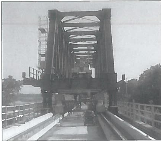
Figura 59 - Traslazione travata
