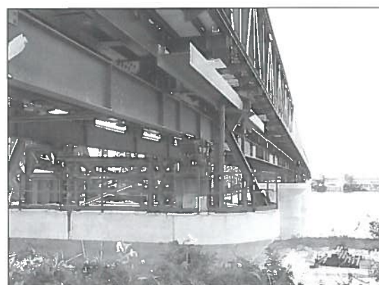
Figura 85 - Travi di contrasto orizzontali
