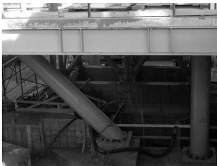
**Fig. 5.** Colonna inclinata per evitare interferenze con fondazione
