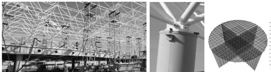
**Fig. 13.** Vista copertura MERO e appoggio su colonne in carpenteria (realizzazione e modello).
