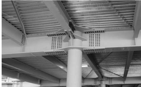
**Fig. 9.** Orditura 1° impalcato con stabilizzatori
