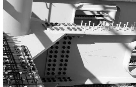
**Fig. 10.** Dettaglio piolatura travi
