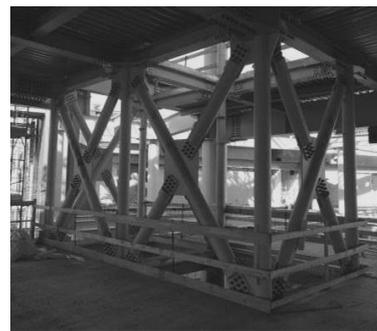
**Fig. 6.** Controventi verticali attorno a vano ascensori
