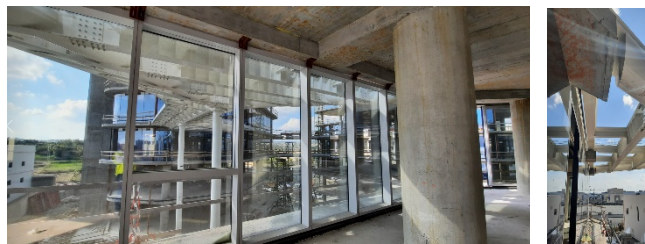
Fig. 9. Vista delle colonne in acciaio e delle mensole di appoggio - Impalcato tipo 1
