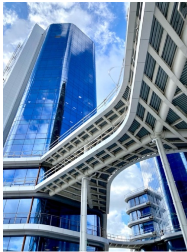
Fig. 26. Impalcato tipo 1 – Q4/Q3 Strutture a vista dell'impalcato
