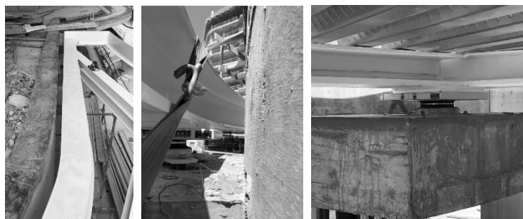
Fig. 20. Fase di grouting appoggi e controllo dimensionale giunti strutturali
