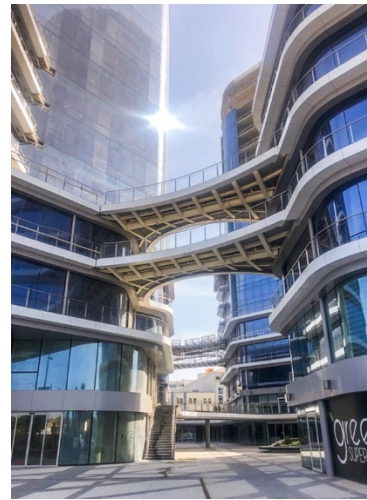
Fig. 27. Scorcio del podio inferiore e superiore con vista dei 4 ponti a campata unica
