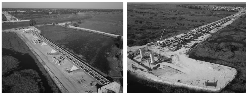
Fig. 7. Foto aerea delle aree di cantiere rispettivamente lato Torre 1 (sx) e lato Torre 2 (dx)
