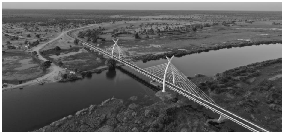
Fig. 1. Okavango River Bridge - Vista d'insieme della struttura completa
