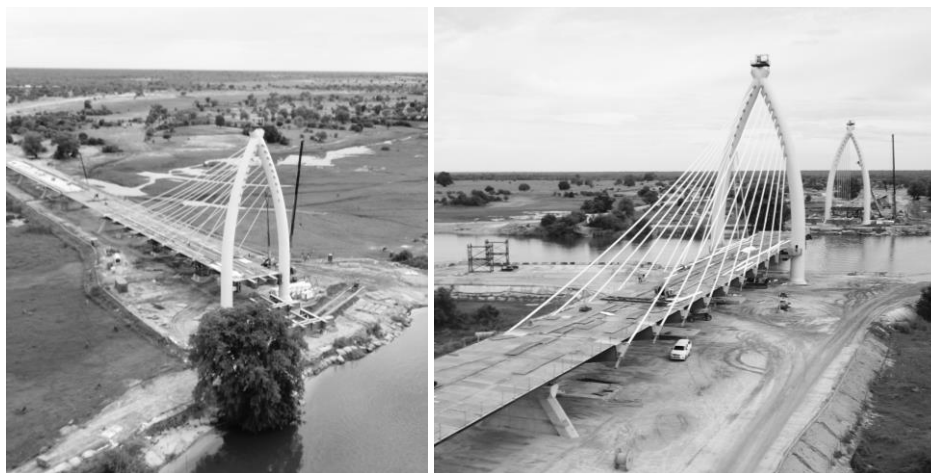
Fig. 9. Fase di pretesatura: rispettivamente lato Torre 1 (sinistra) e lato Torre 2 (destra)
