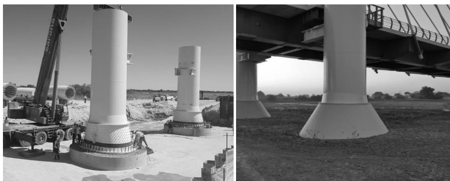
Fig. 6. Dettaglio dell'incastro di base delle antenne in fase di montaggio ed a montaggio completo
