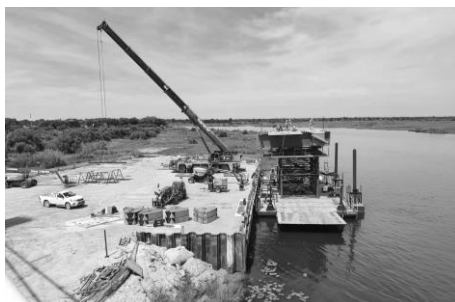
Fig. 8. Banchina di carico del pontone per la movimentazione conci in alveo
