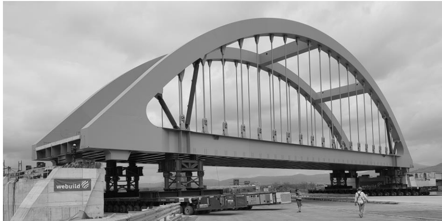
Fig. 3. Viadotto ad arco VI03 in fase di varo
