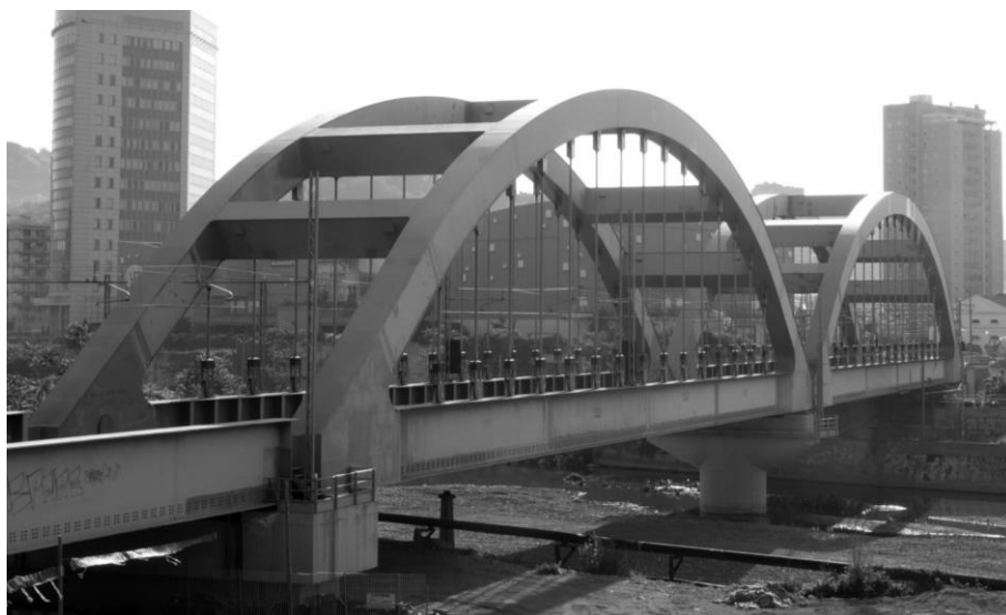
Fig. 2. Viadotto Polcevera a Genova
