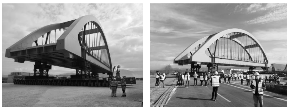
Fig. 11. Impalcato su carrelloni prima e durante la manovra
