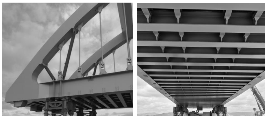
Fig. 6. Particolare trave catena all'innesto e tavolato
