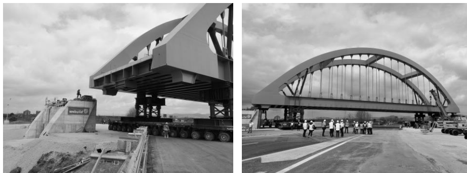
Fig. 12. Avvicinamento e allineamento agli appoggi definitivi - Calaggio
