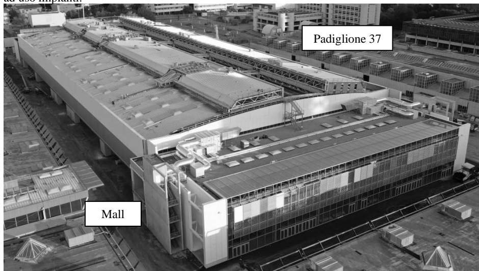
Fig. 1. Vista esterna del padiglione con copertura aperta
