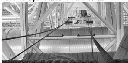
Fig. 8. Vista interna del sistema di funi
