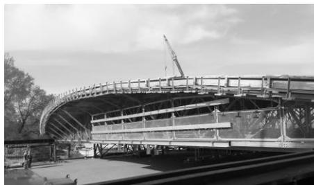
Fig. 16. Completamento con pannelli ed impianti di illuminazione
