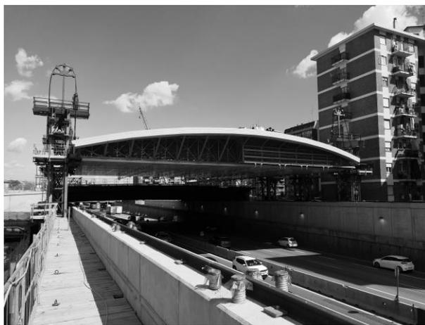
Fig. 22. Presa in carico con strand jack
