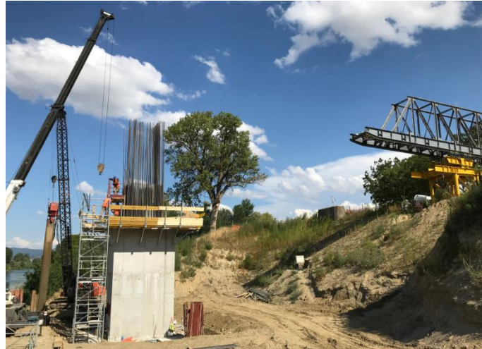
Fig.3. Vista della pila intermedia e avambecco in avanzamento
