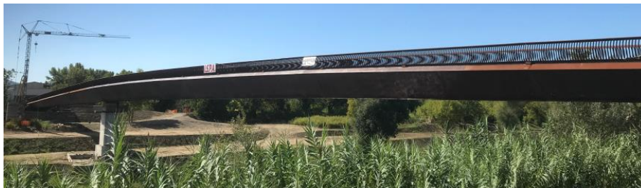
Fig.4. Passerella in vista della conclusione.
