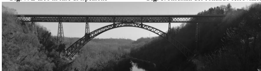
Fig. 9. Un treno in transito sul Ponte San Michele dopo il termine dei lavori
