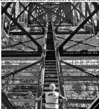
Fig. 7. L’arco in fase di ispezione
