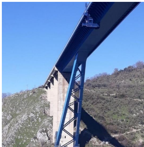
Fig. 4. Viadotto Platano su RA 5
