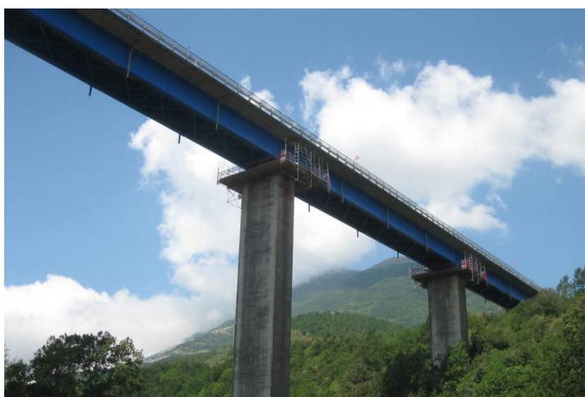
Fig. 3. Viadotto Prodino Grande, SS 585 fondovalle del Noce
