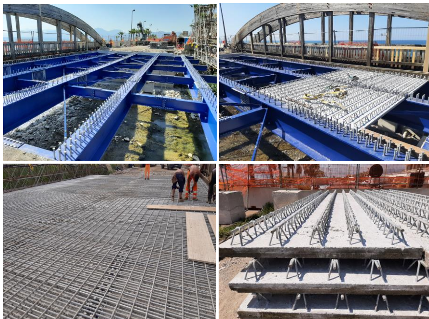
Fig. 6. Realizzazione impalcato
