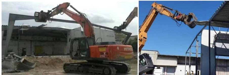
Fig. 5. Edificio mercato a Colonia: fasi della demolizione selettiva della struttura, a sinistra, e del rivestimento di copertura, a destra (fonte: [3])
