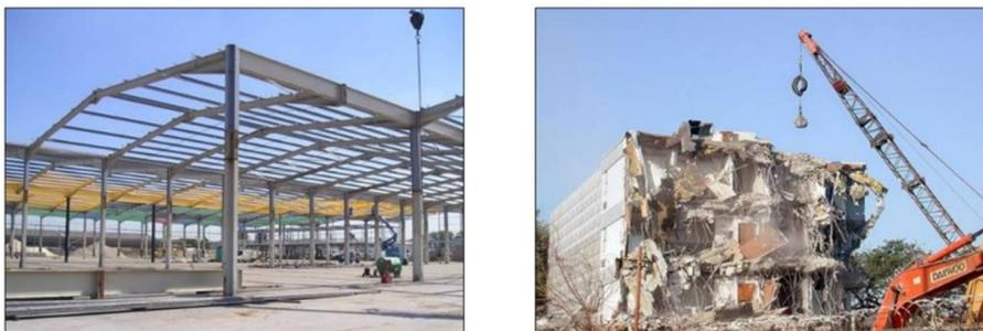
**Fig. 1.** Sistemi costruttivi con differenti scenari di fine vita: a sinistra, *upcycling* (decostruzione e riutilizzo); a destra, *downcycling* (demolizione tradizionale e frantumazione)
