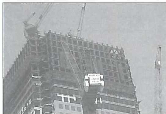
Fig. 5 - Sollevamento di una porzione prefabbricata di una struttura reticolare spaziale
