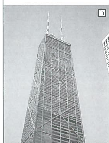
Fig. 10 - La forma troncopiramidale diagonalizzata del John Hancock Center di Chicago
