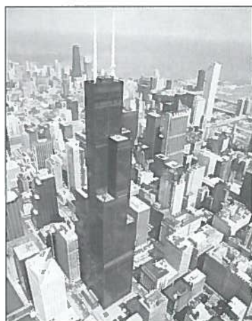
Fig. 7 - Il Sears Building di Chicago
