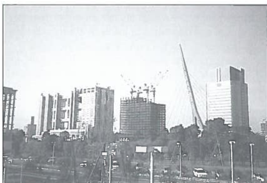
Fig. 41 – Edificio con struttura resistente a telaio in costruzione a Tokyo
