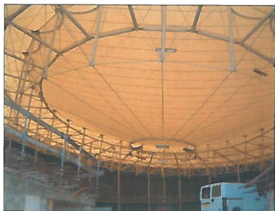
Rinaldo Passera - Il Centro mondiale del ciclismo a Aigle (CH) - Cellule bipiramidali della membrana inferiore
