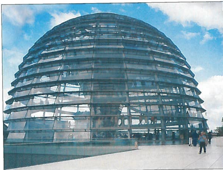
Andrea Campioli - Il progetto di Norman Foster per il Reichstag a Berlino, ultimato nel 2000 è emblematico di una serie di progetti di riqualificazione architettonica mirati alla ridefinizione degli spazi degli edifici attraverso la realizzazione di coperture trasparenti.
