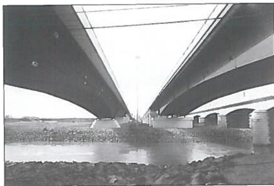
Fig. 1 Vista d'insieme dei tre ponti dalla riva sinistra del Tevere. A sinistra il nuovo ponte, a destra il ponte allargato e sullo sfondo il primo ponte in c.a.
