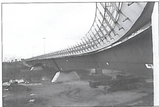
Fig. 2 Vista del nuovo ponte dalla spalla in corrispondenza dell'allargamento per lo svincolo.
