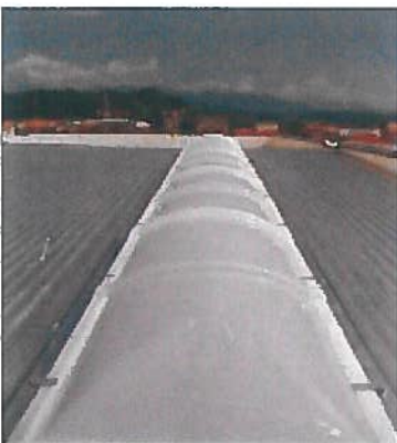
Zenit Srl - Lucernario Continuo Termoformato componibile con forma a Vela "Zenit Skylight TDV", ottenuto mediante termoformatura di lastre piane prodotte esclusivamente con granulo originale, esente da monomero di recupero.
