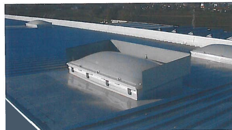
Scobalit Italia Srl - Evacuatore di fumo e calore installato in copertura tramite elemento di supporto.
