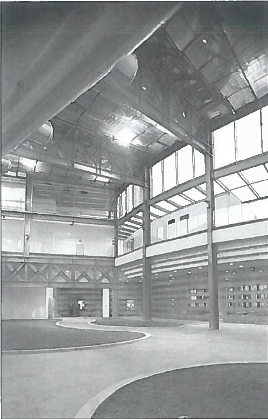
Fig. 8. Vista della hall d'ingresso verso la zona mensa.
