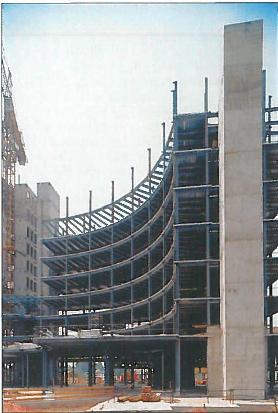
Fig. 16. Vista di un'ala dell'edificio in fase di costruzione, con in primo piano una 'torre' del vano ascensore.
