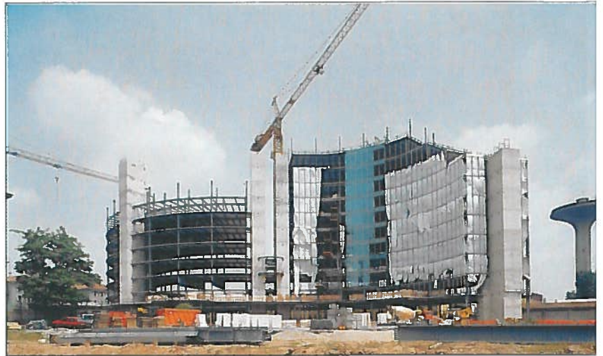
Fig. 17. Vista dell'edificio in fase di costruzione.
