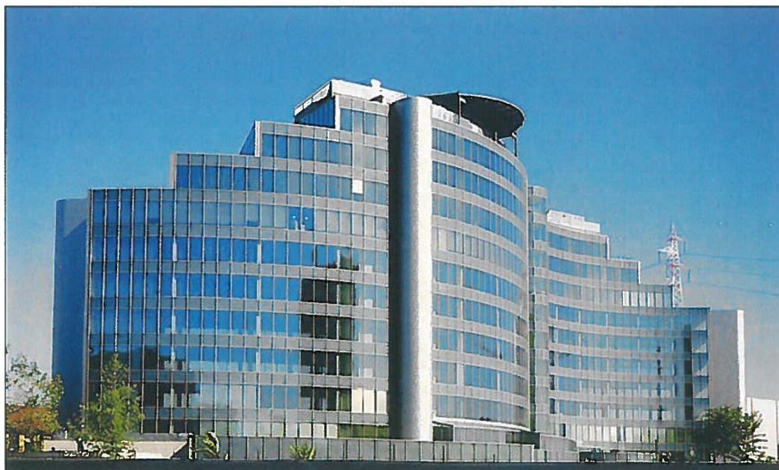
Fig. 1. Vista del fronte ovest dell'edificio.
