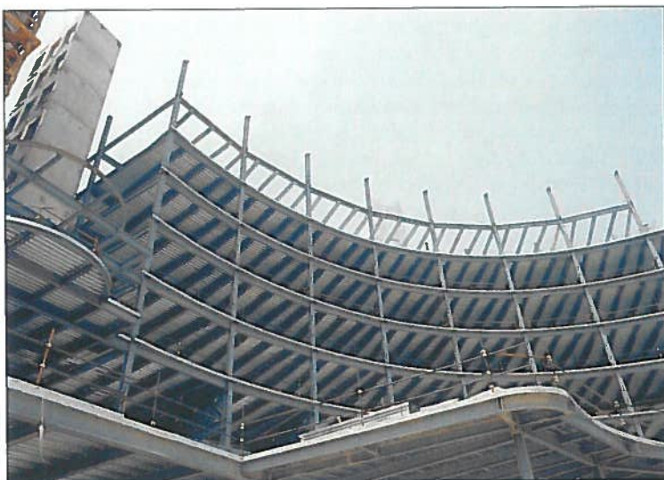
Fig. 24. Vista della struttura portante in acciaio in profili IPE e dei solai in lamiera grecata durante la fase di costruzione.
