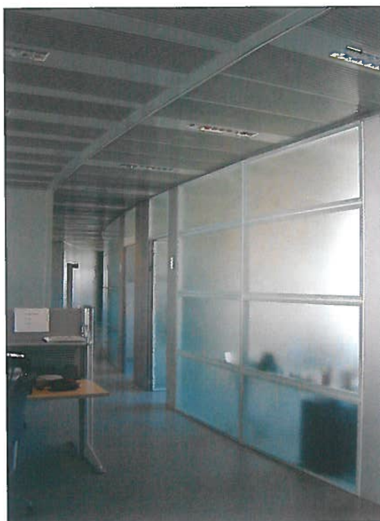
Fig. 13. Vista dei sistemi di partizione interna.
