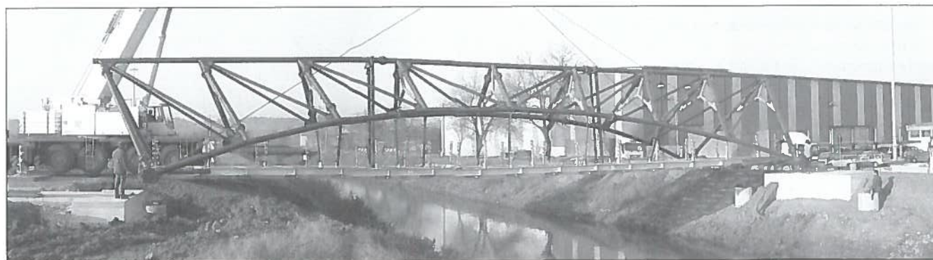
Fig. 10 - Il varo della passerella: sollevamento con una gru posta in sponda destra
