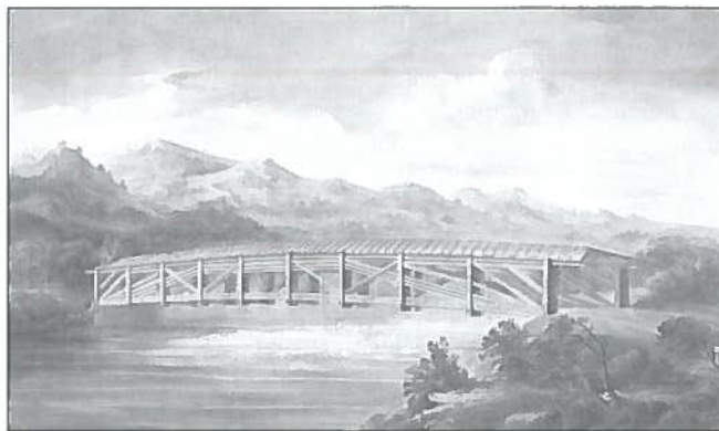
Fig. 3 - Ponte di Ziegelbrücke, tratto da "John Soane e i ponti di legno svizzeri" (op. cit.)
