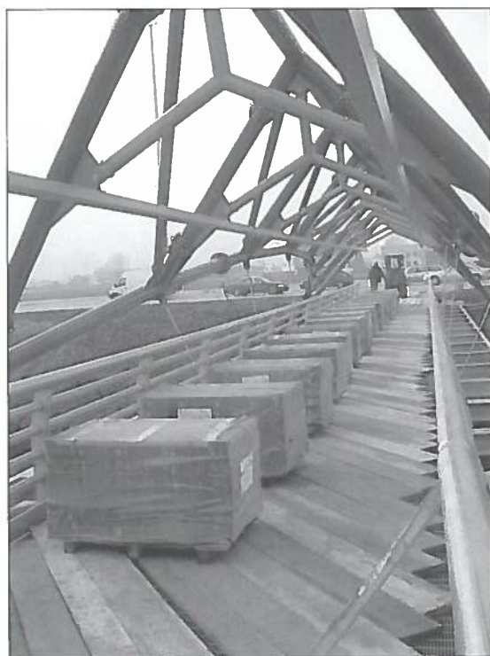
Fig. 11 Prova di carico con elementi di acciaio
