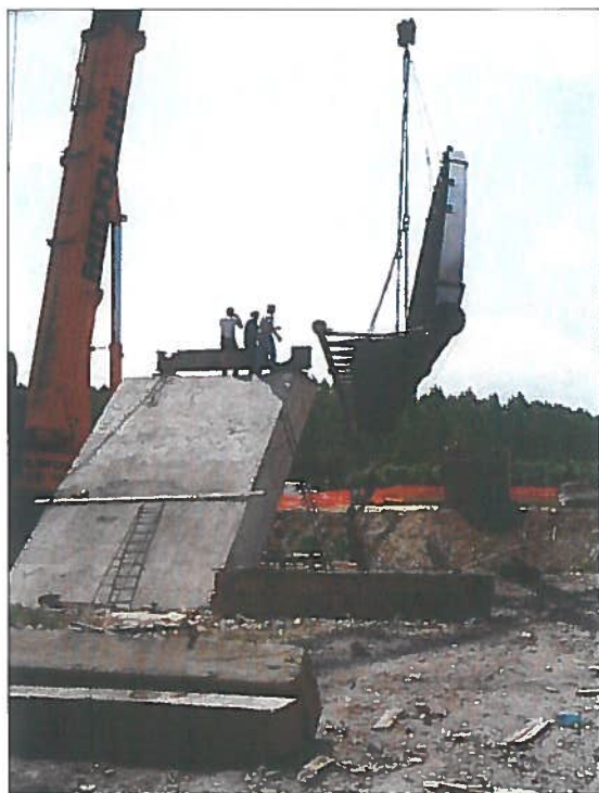
Figura 15 Fase di varo con autogrù da 4000 kN.
