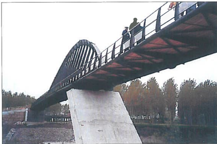
Figura 1 Vista del ponte dal basso.
