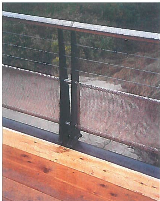
Figura 14 Vista del parapetto.
