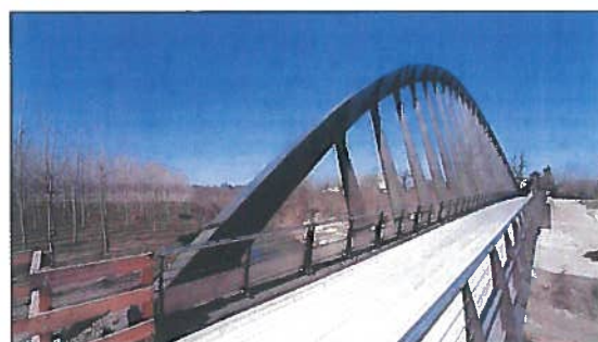
Figura 5 Vista durante l'attraversamento.
