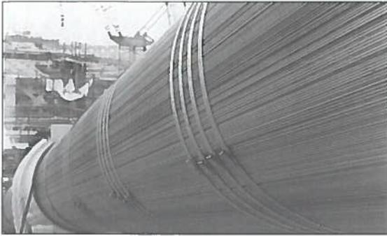
Figura 42 - Cavo principale di ponte sospeso
