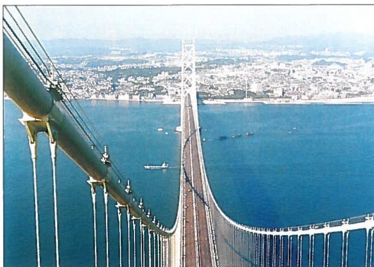
Figura 1 – L' Akashi Kaikyo Bridge, completato nel 1998 (foto P. Clemente)
