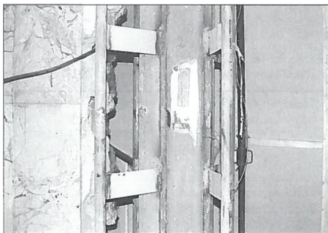
28. Posizionamento di un estensimetro elettroresistivo sulla parete di un tirante.
