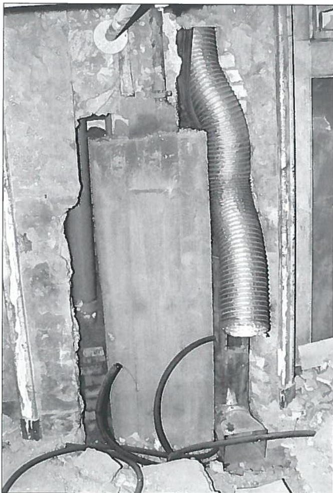
13 . Blocco in conglomerato cementizio additivato per la protezione di una base di colonna.
