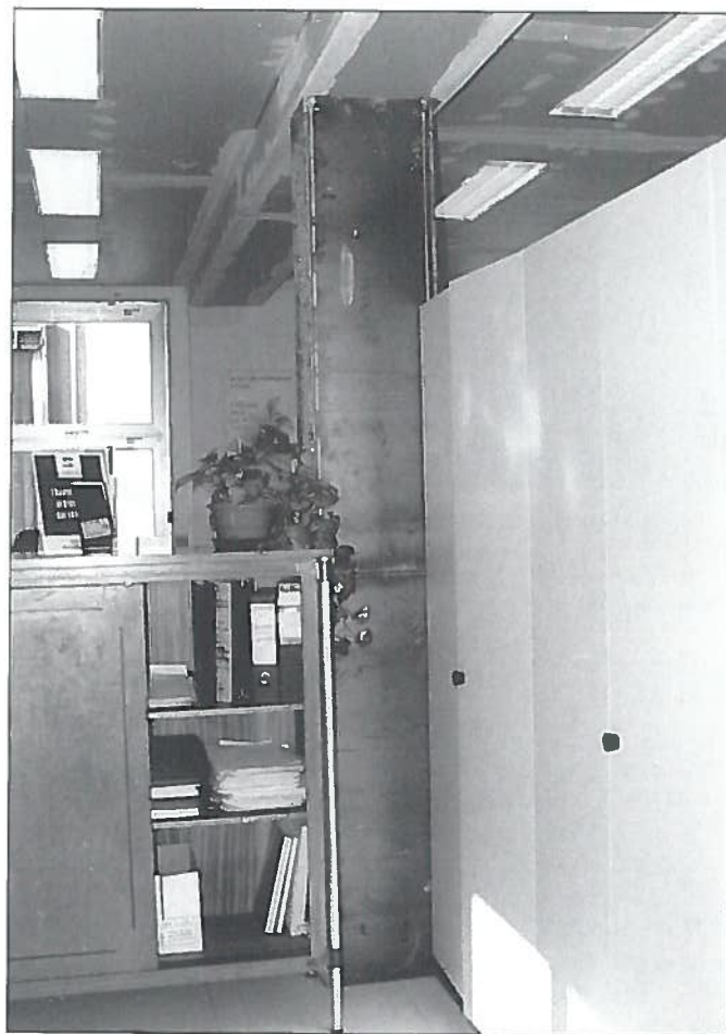
16. Colonna "scatolata" con lamiera d'acciaio e riempita di conglomerato cementizio di tipo espansivo. 16. The column is closed with steel plates and filled with expansive concrete.
