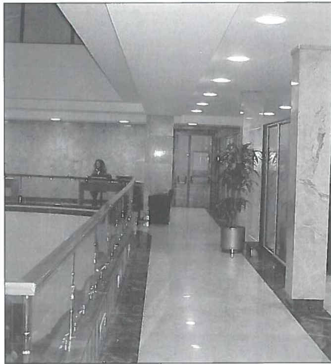
15. Livello dove i tiranti sfalsati sono stati precompressi mediante barre Dywidag (a lavori ultimati).
