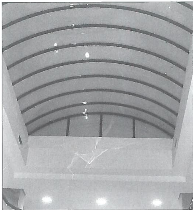
14. Volta in materiale traslucido per l'illuminazione del salone (a lavori ultimati).
