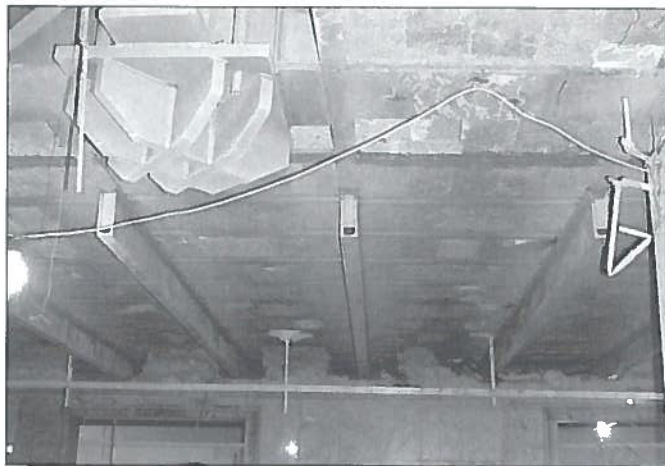
34. Vista laterale dei profili di rinforzo saldati al di sotto dell'ala inferiore delle travi secondarie d'impalcato.
