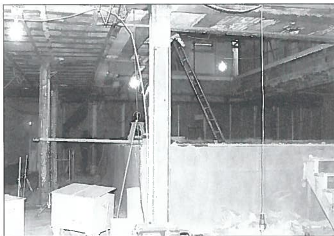
23. Tiranti fra il primo ed il secondo livello sottoposti all'intervento tipo C con riempimento di conglomerato espansivo e precompressione mediante barre Dywidag.
