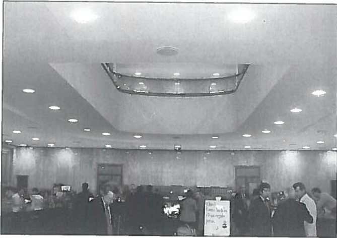
4. Come si presenta il salone a piano terra, completamente libero da strutture verticali, grazie al sistema di sospensione dei piani superiori (a lavori ultimati). 4. The view of the ground floor completely clear of vertical structures, thanks to the hanging system of the upper floors (after intervention).
