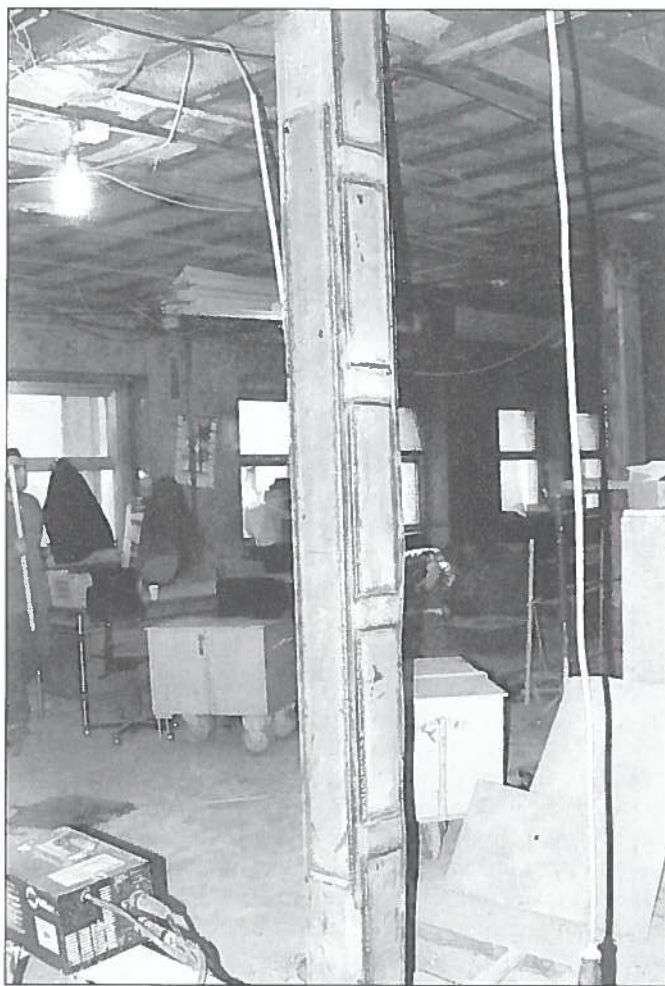
21. Il tirante è stato "scatolato" mediante lamiere saldate, prima di essere riempito di conglomerato.
