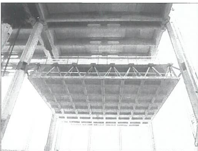
Fig. 21 - Sollevamento e posizionamento finale della piastra composita. Fig. 21 - Hoisting and final positioning of the composite plate.
