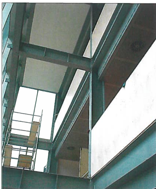
Fig. 3 La chiarezza strutturale dell'edificio viene avvalorata dall'uso di materiali semplici e non trattati, di facile identificazione e di riconoscibile matrice industriale
