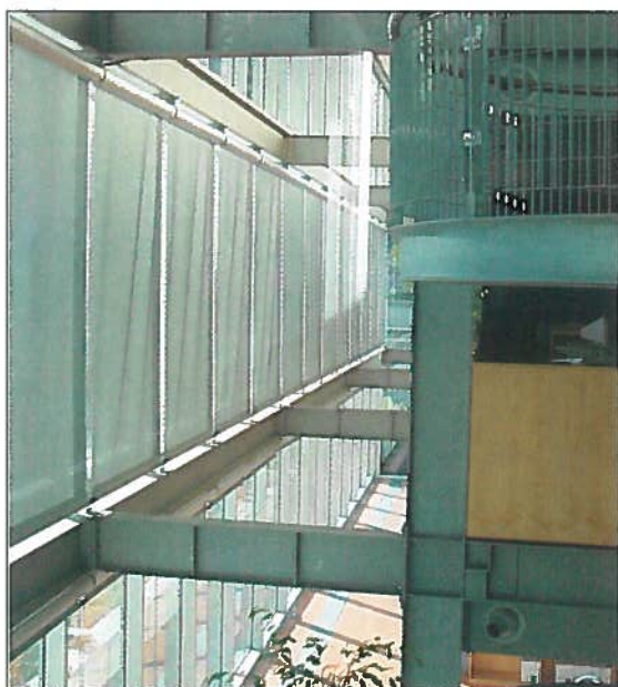
Fig. 10 I vetri del lato sud sono ad alta resa energetica protetti esternamente da brise soleil e internamente da tende. Le travi a sbalzo sostengono l'intera vetrata
