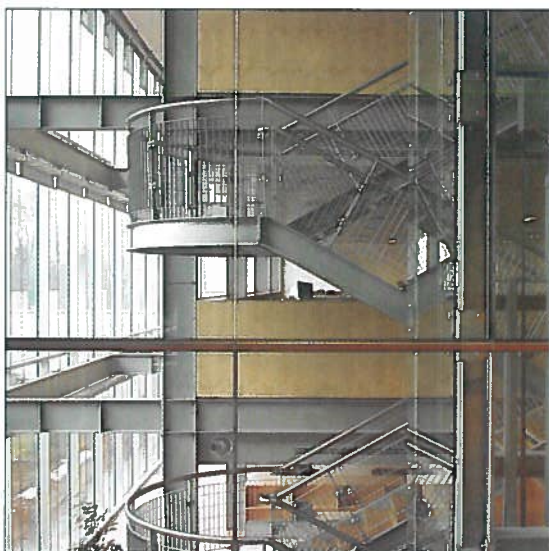
Fig. 8 Le scale metalliche si trovano all'interno del grande volume vetrato a tutta altezza che ha funzione di controllo microclimatico di tutti gli ambienti.
