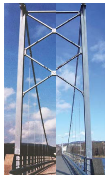
Il Ponte Kalvoya in Norvegia è stato trattato con ZINGA nel 1985. Dopo 30 anni, il ponte è ancora in buone condizioni.
