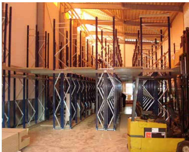
Fig. 4 - Scaffalature leggere con passerella.
