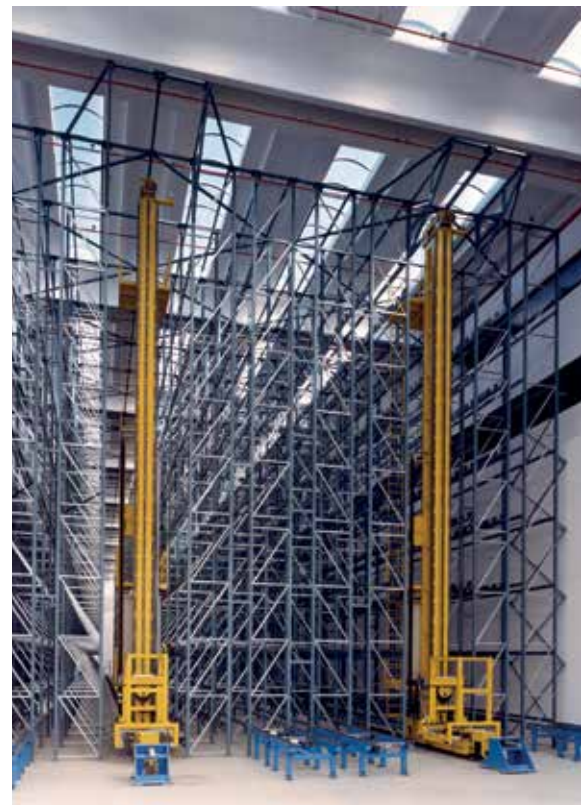
Fig. 1 - Magazzino portapallet con trasloelevatori.
