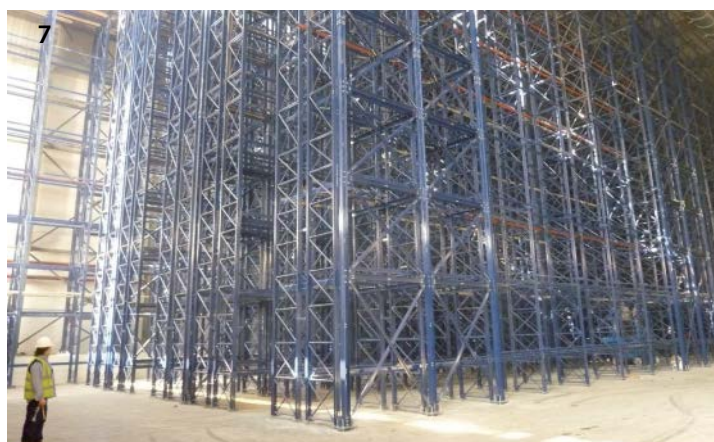
Fig. 7 - Impianto automatico in zona sismica in avanzato stato di montaggio. Si nota l'ampia diffusione di controventature, sia nel piano longitudinale che nel piano trasversale, per garantire la stabilità della struttura al verificarsi di azioni sismiche orizzontali. Fig. 8 - Anche strutture multilivello destinate all'archiviazione possono essere convenientemente dimensionate per esistere alle azioni sismiche. In questo caso si notano i due corpi di impianto destinati allo stoccaggio e il terzo corpo per le scale
