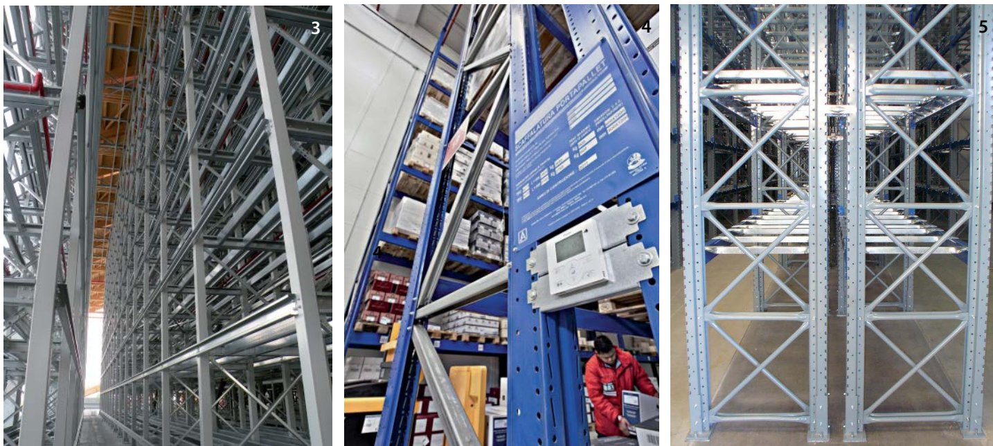
Fig. 3 - Nella progettazione antisismica è frequentemente richiesta la realizzazione di collegamenti bullonati ad efficienza maggiorata, realizzati con il raddoppio delle bullonature. Fig. 4 - La progettazione antisismica richiede attenzioni speciali in tutti i sistemi di connessione tra i componenti dell'impianto. Si nota il collegamento tra il montante e la tralicciatura ottimizzato per non trasmettere torsione al montante stesso. Fig. 5 - Vista ravvicinata di una spalla per scaffalatura porta pallet antisismica. Lo schema di tralicciatura ad X non è l'unico utilizzabile, ma sicuramente uno dei più efficaci per resistere alle azioni sismiche in direzione trasversale
