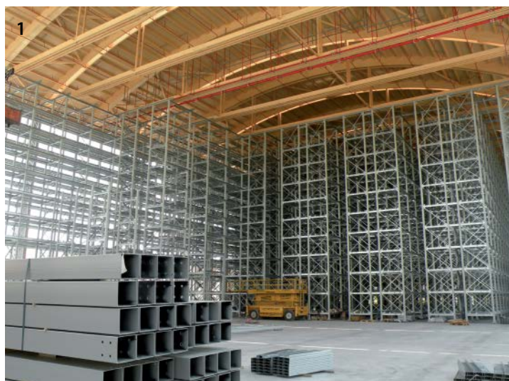
Fig. 1 - Impianto porta pallet automatico in zona ad alta sismicità: le caratteristiche locali e le specifiche del cliente richiedono sempre una progettazione specifica e specializzata. Fig. 2 - Impianto porta pallet di grande altezza in zona sismica. La regolarità geometrica in entrambe le direzioni principali della struttura, è uno dei principali requisiti di una progettazione efficiente
