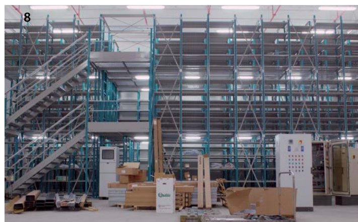
Fig. 7 - Impianto automatico in zona sismica in avanzato stato di montaggio. Si nota l'ampia diffusione di controventature, sia nel piano longitudinale che nel piano trasversale, per garantire la stabilità della struttura al verificarsi di azioni sismiche orizzontali. Fig. 8 - Anche strutture multilivello destinate all'archiviazione possono essere convenientemente dimensionate per esistere alle azioni sismiche. In questo caso si notano i due corpi di impianto destinati allo stoccaggio e il terzo corpo per le scale
