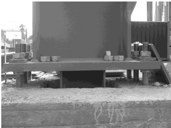
Figura C13.4 – Uso dei dadi di livellamento sotto la piastra di base
