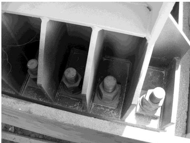
Figura C13.5 – Rondelle quadrate di grosso spessore per compensare i fori maggiorati nelle piastre di base
