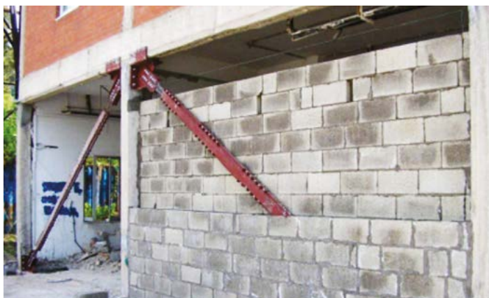
Fig. 3 - Posizionamento del controvento BRB nell'intercapedine fra i due pannelli della tamponatura esterna
