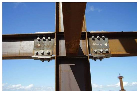
b) “Sliding hinge joint” con dissipatori ad attrito asimmetrici sul progetto premiato Te Puni Village of Wellington - [13]
