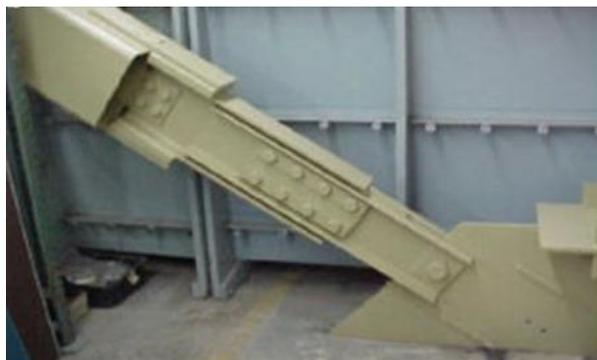
b) Dispositivo di Pall installato in una singola diagonale di controvento presso la Boeing Commercial Airplane Factory Everett, USA - (Cortesia: Dr Pall)
