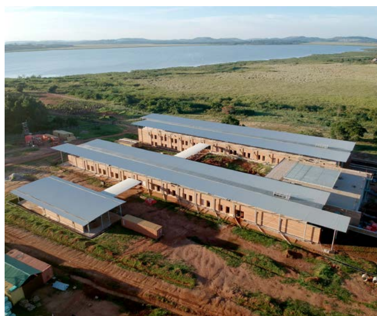
Fig. 3 - Vista dall'alto del centro. © Emergency NGO Technical Department
