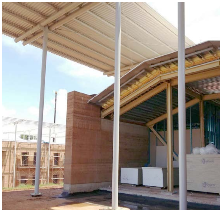
Fig. 44– Vista dell'intradosso del sistema di ombreggiamento dell'ala sud in corrispondenza del fronte ovest. © Emergency NGO Technical Department
