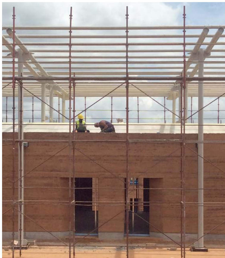
Fig. 27 - Montaggio della struttura di acciaio del sistema di ombreggiamento. © Emergency NGO Technical Department
