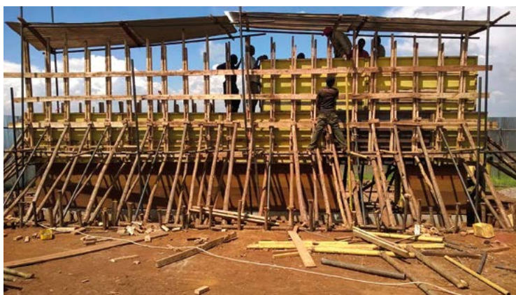
Fig.18 – Costruzione del mock up della muratura in pisé. © Emergency NGO Technical Department
