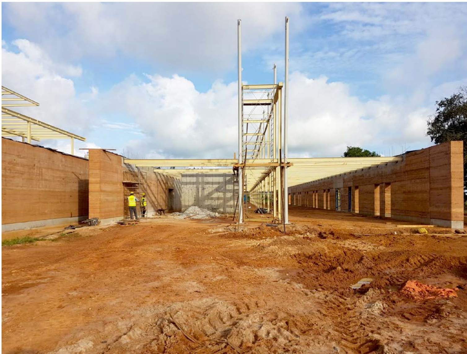
Fig. 38 – Costruzione della carpenteria di acciaio dell'ala nord. © Emergency NGO Technical Department
