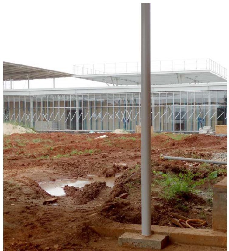
Fig. 47 - Vista dell'affaccio del corpo centrale sulla corte. © Emergency NGO Technical Department
