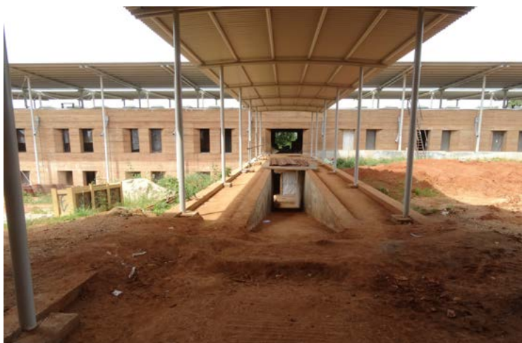
Fig. 6 - Pensilina di collegamento tra accettazione, ala sud e ala nord. © Emergency NGO Technical Department
