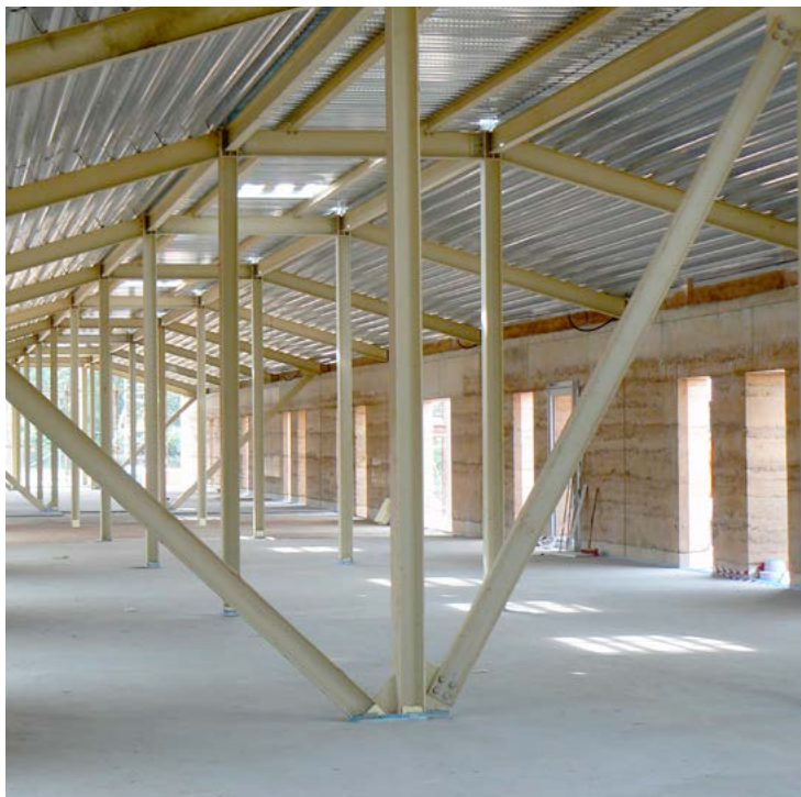
Fig. 36 - Vista dell'intradosso del solaio di copertura dell'ala sud. © Emergency NGO Technical Department
