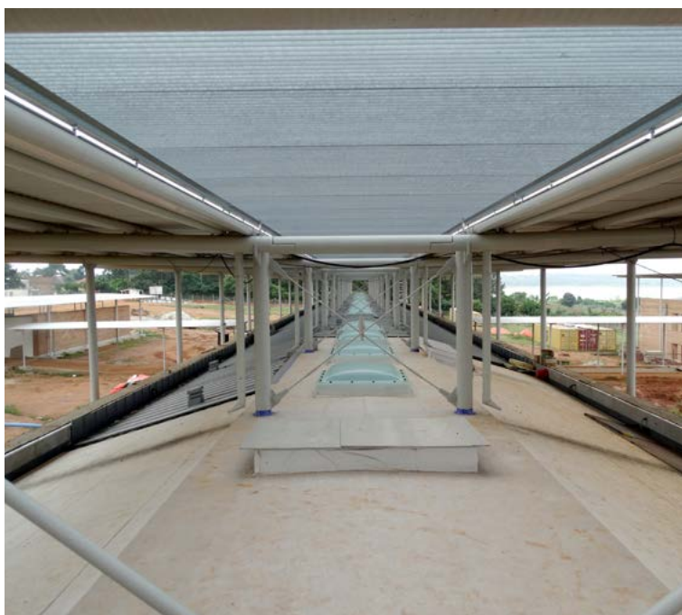
Fig. 39 – Vista della copertura e dell'intradosso del sistema di ombreggiamento dell'ala sud. © Emergency NGO Technical Department
