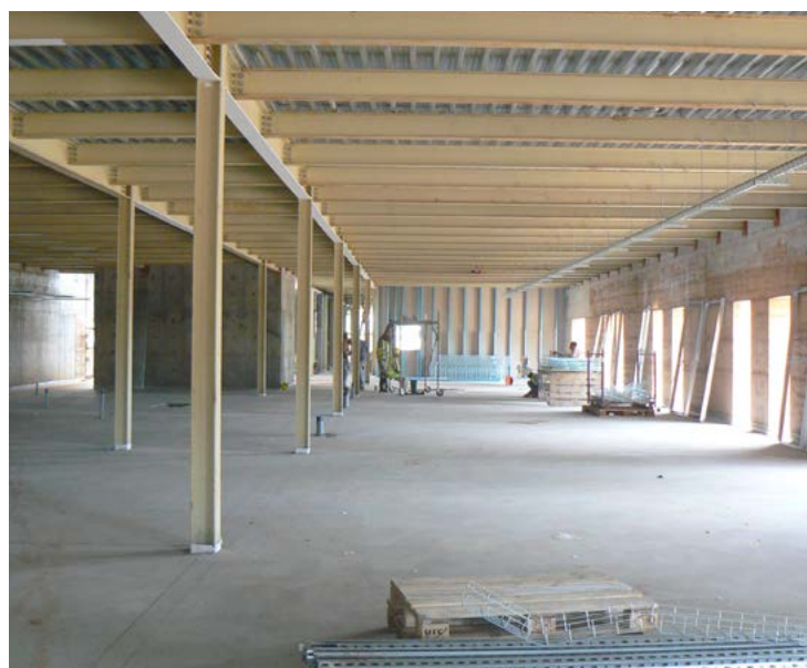
Fig. 33 - Vista dell'intradosso del solaio intermedio dell'ala nord. © Emergency NGO Technical Department
