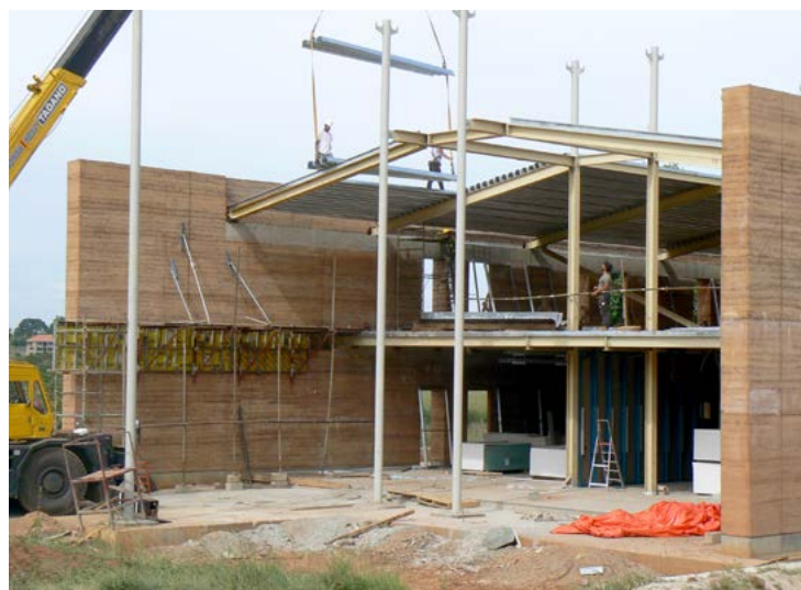
Fig. 32 - Montaggio del solaio di copertura dell'ala nord. © Emergency NGO Technical Department
