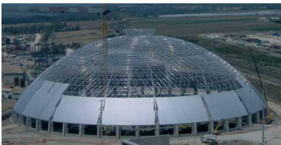
Fig. 3.5 - Struttura da esterno
