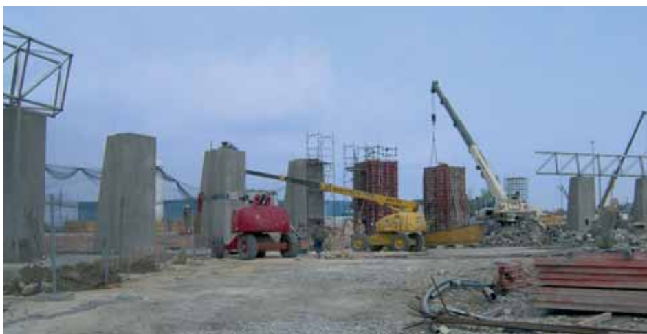
Fig. 4.3 - Completamento pilastri
